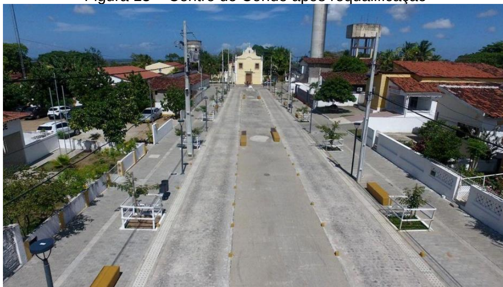
Figura 13 – Centro de Conde após requalificação
