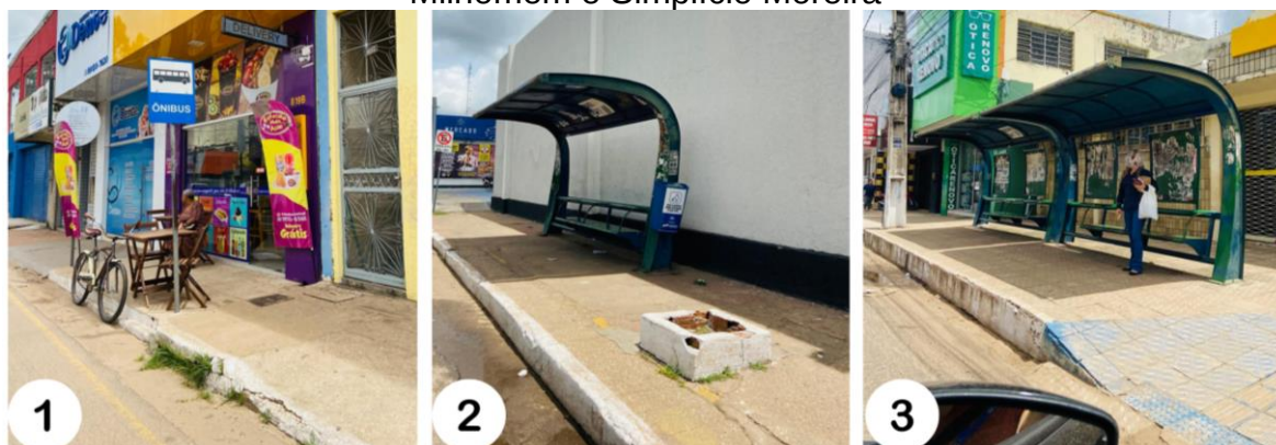
Figura 44 – Pontos de ônibus da Avenida Dorgival Pinheiro de Sousa. 1) Entre as ruas Ceará e Piauí/ 2) Entre as ruas Pará e Amazonas/ 3) Entre as ruas Coriol. Milhomem e Simplício Moreira
