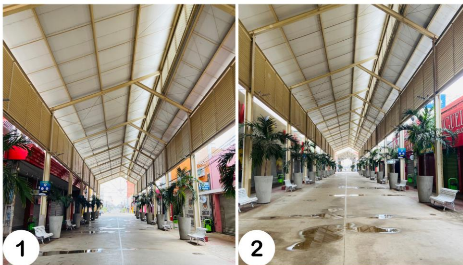
Figura 63 – 1) Cobertura metálica presente no segmento A/ 2) Cobertura metálica presente no segmento B
