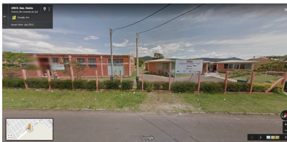
Figura 1 – Frente do Centro de Referência de Assistência Social, Rua General Osório
