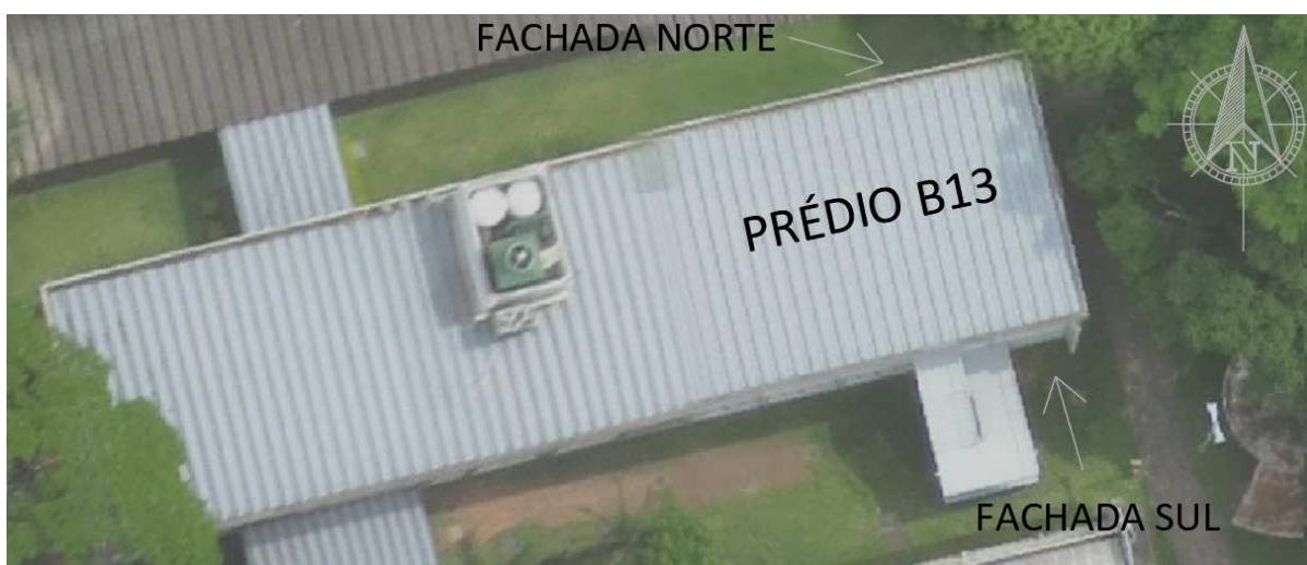
Figura 20 – Vista superior do prédio B13 e indicação das fachadas
