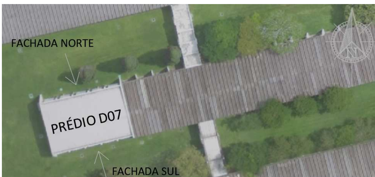
Figura 21 – Vista superior do prédio D07 e indicação das fachadas
