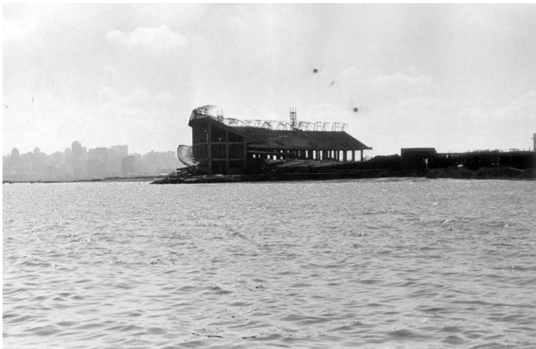
Figura 14. Mirada pelo Guaíba, se ergue a construção do Estádio do Internacional. Década de 1960.
