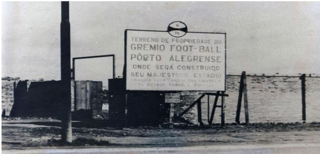
Figura 4. Placa informando a construção do futuro estádio do Grêmio em 1951 (Acervo do Clube, Museu Hermínio Bittencourt).
