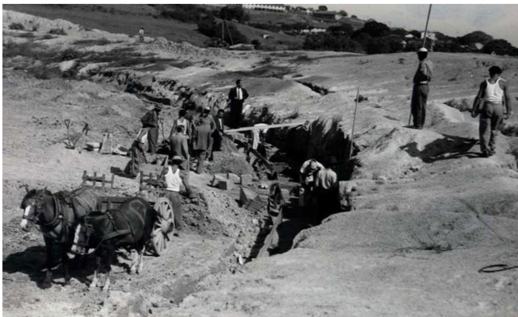
Figura 6. Terraplanagem no local que será erguido o Estádio Olímpico. (Acervo do Grêmio Foot Ball Porto Alegrense, Memorial Hermínio Bittencourt), s/a e s/d.
