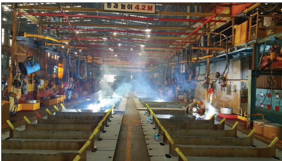
Figura 96 – Processo de submontagem na Coreia do Sul
