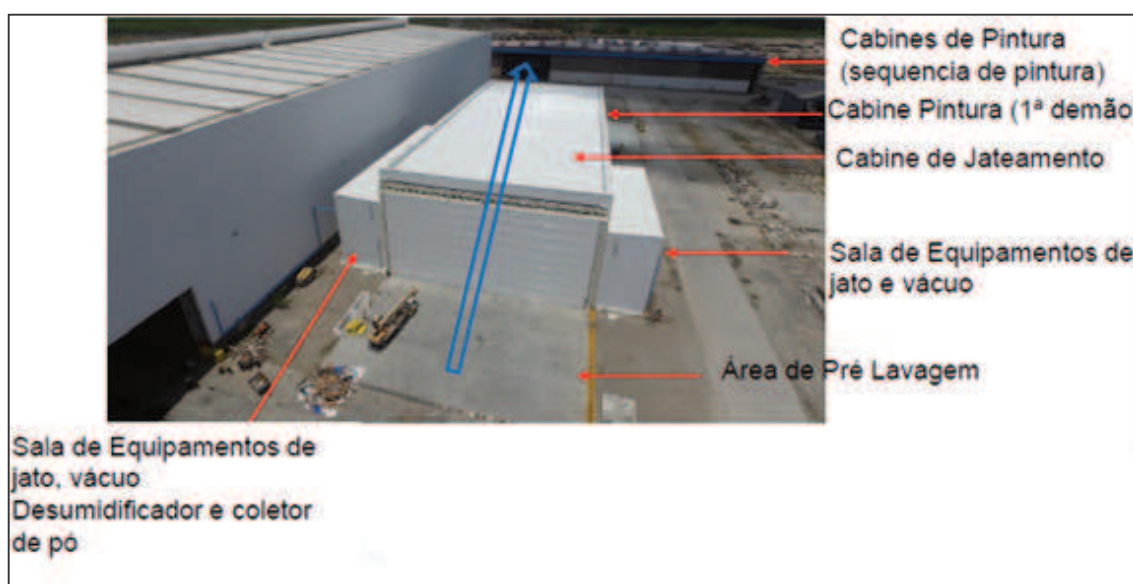
Figura 53 – Nova cabine de jato e pintura
