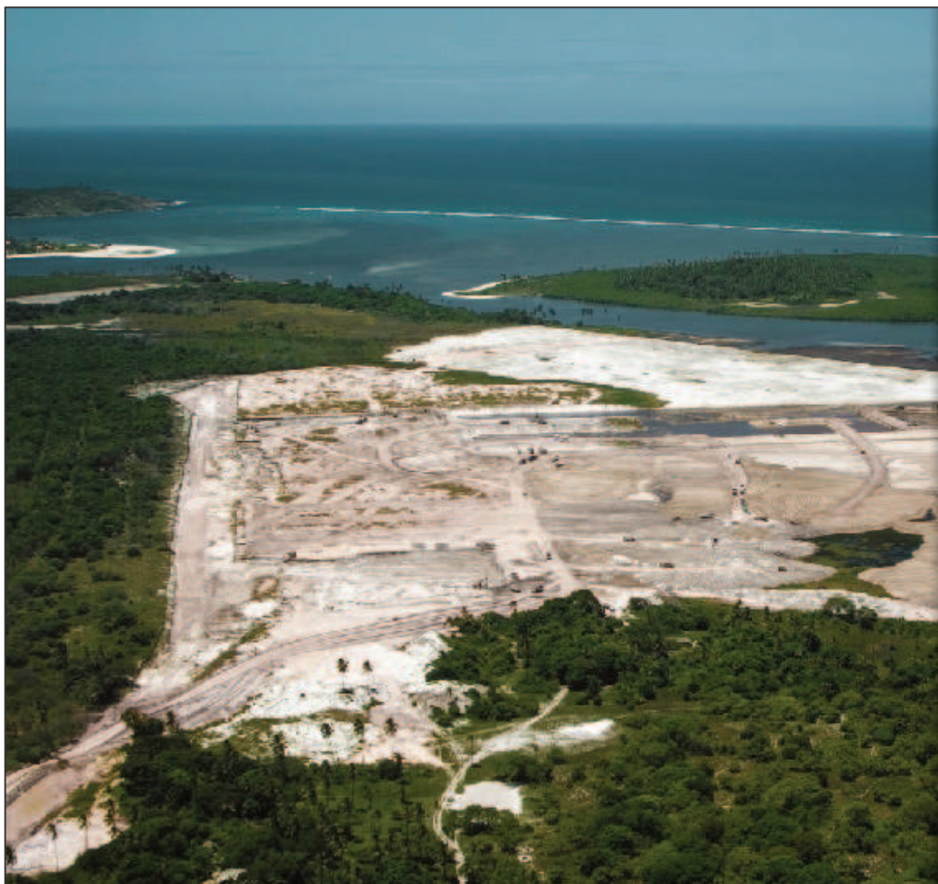
Figura 5 – Obras para planta
