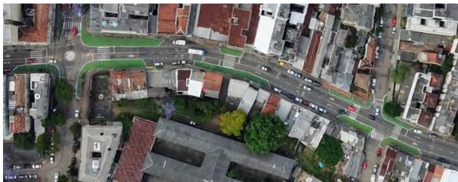
Figura 15 – Rua João Alfredo após a conclusão da fase temporária
