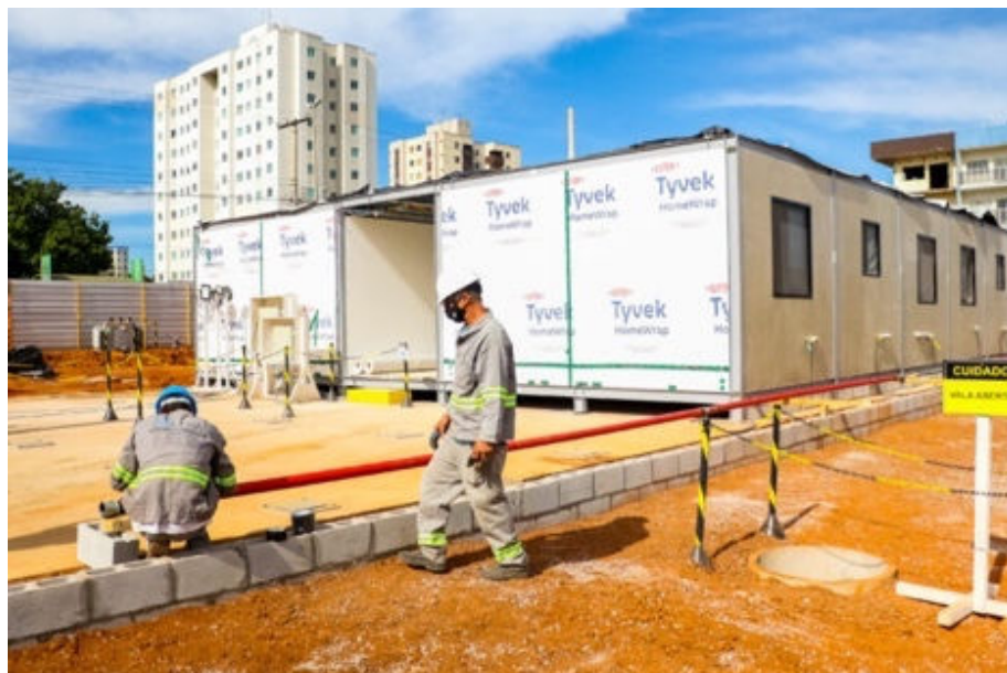
Figura 44 – Módulos do Hospital Modular Acoplado de Samambaia
