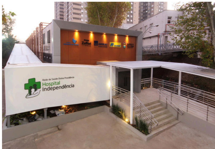
Figura 53 – Acesso e rampa lateral
