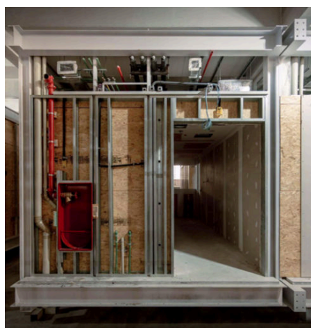
Figura 21 – Previsão de Instalações de Incêndio no Módulo
