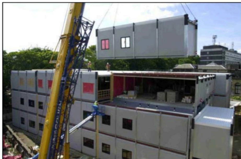
Figura 16 – Edifício Hospitalar Modular durante a instalação de módulos abertos.
