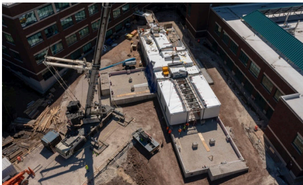
Figura 27 – Vista Aérea Montagem Módulos Advocate Aurora Health
