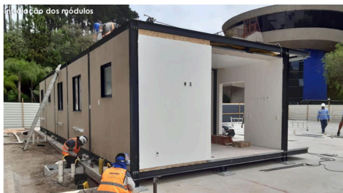
Figura 47 – Instalação dos Módulos
