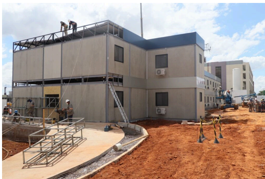
Figura 45 – Montagem do segundo pavimento do Hospital Modular Acoplado de Samambaia
