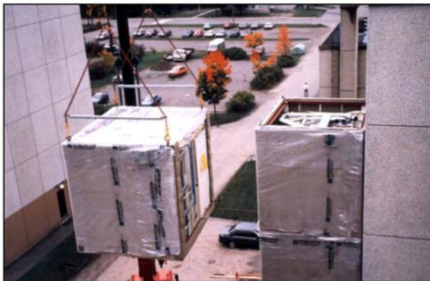
Figura 14 – Módulos de Banheiro abertos sendo anexados a um edifício existente.
