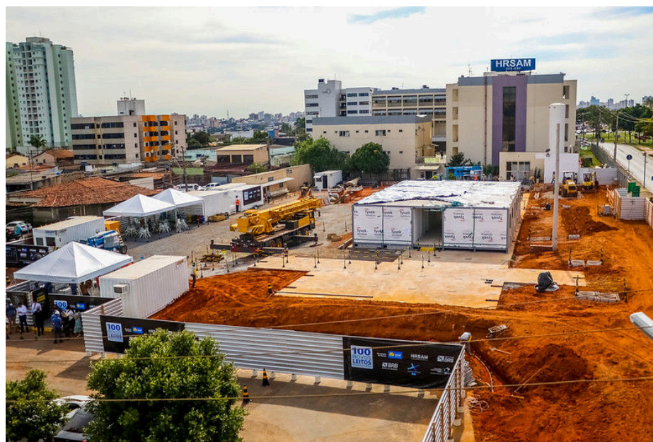
Figura 43 – Construção do Hospital Modular Acoplado de Samambaia
