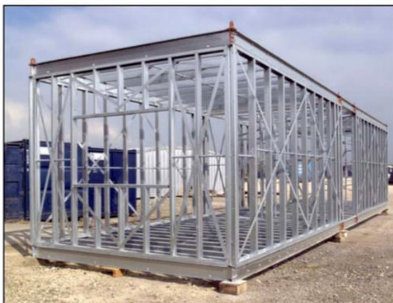
Figura 13 – Módulo longo com corredor
