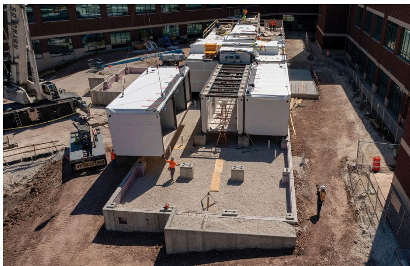
Figura 26 – A instalação de uma unidade modular de observação no Advocate Aurora Health – Grafton Medical Center em Wisconsin
