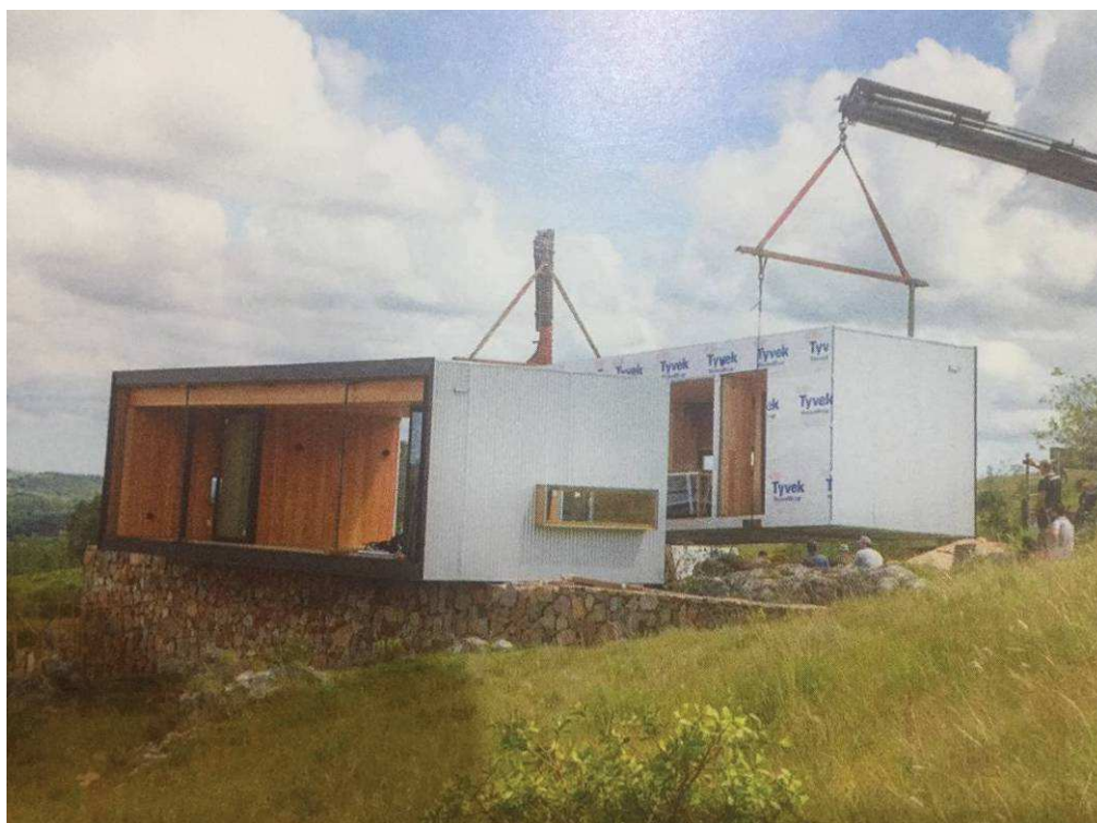
Figura 5 – Módulo Volumétrico sendo posicionado no lote
