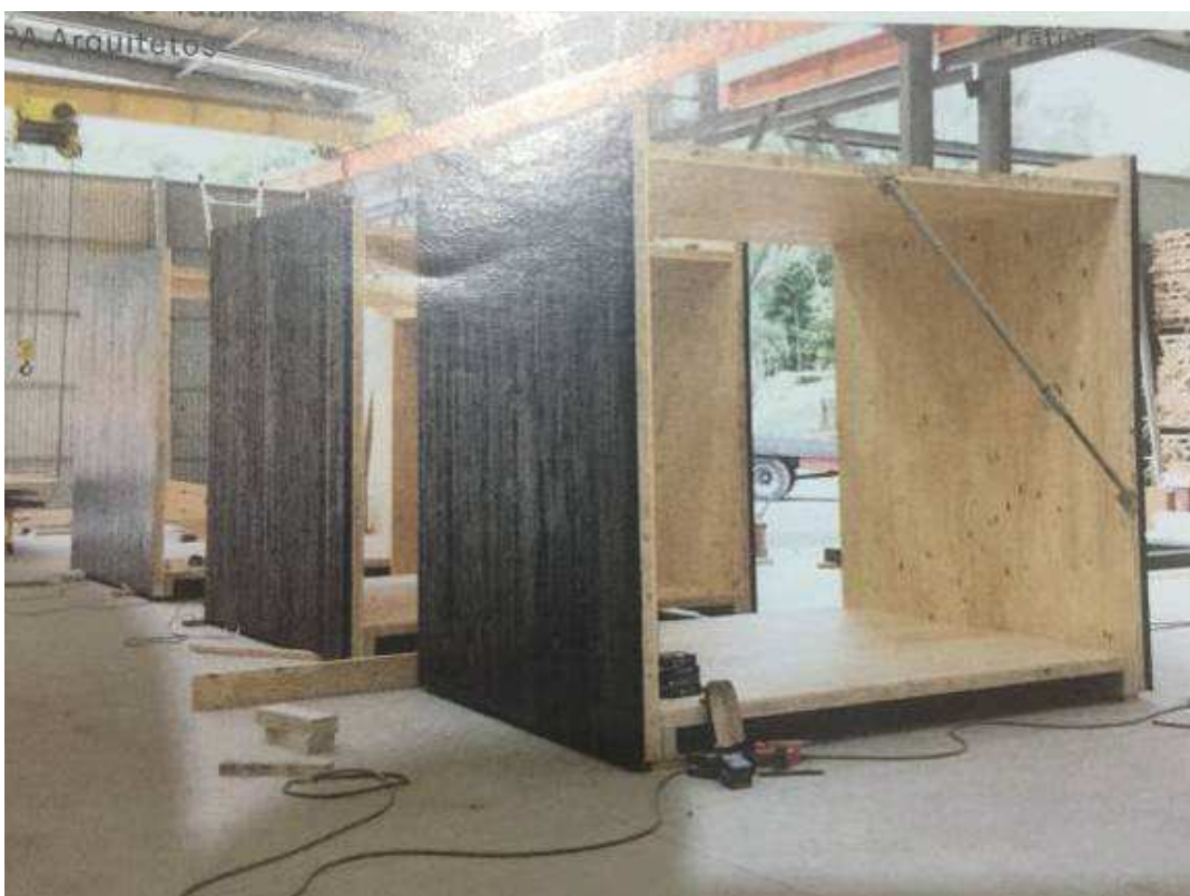
Figura 3 – Módulo Volumétrico sendo produzido na indústria
