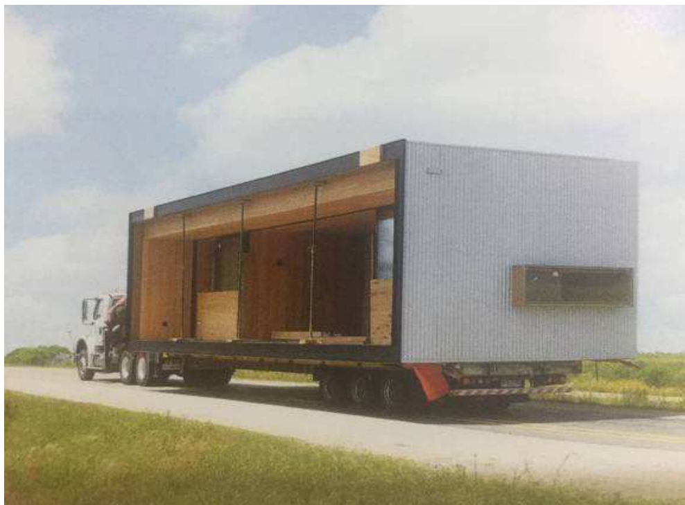
Figura 4 – Módulo Volumétrico sendo transportado
