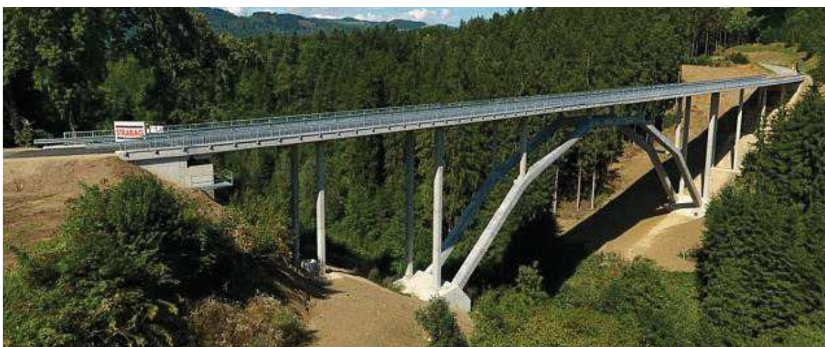
Figura 6 - Ponte confeccionada com UHPC na Áustria
