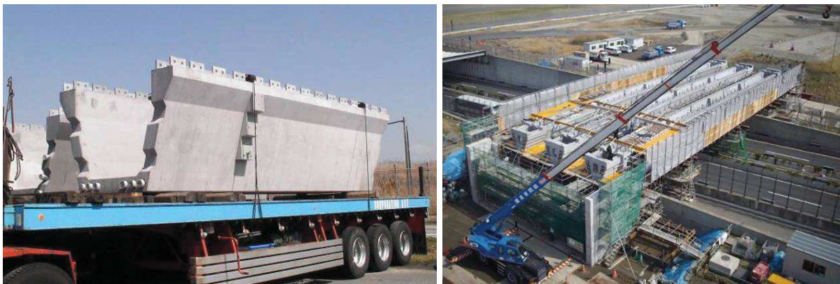
Figura 5 - Peças pré-fabricadas, montagem e detalhamento da concepção da ponte.
