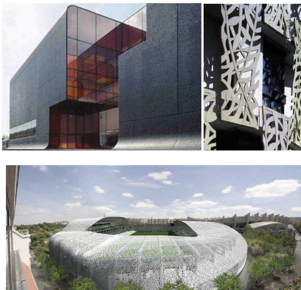
Figura 9 - Painéis decorativos de fachadas confeccionadas com UHPC na França
