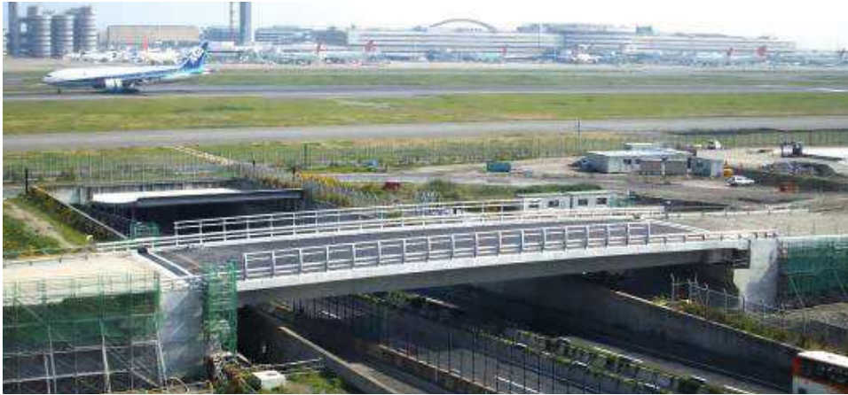
Figura 4 - Ponte no aeroporto de Tóquio, com 46 metros de comprimento e 16 metros de largura
