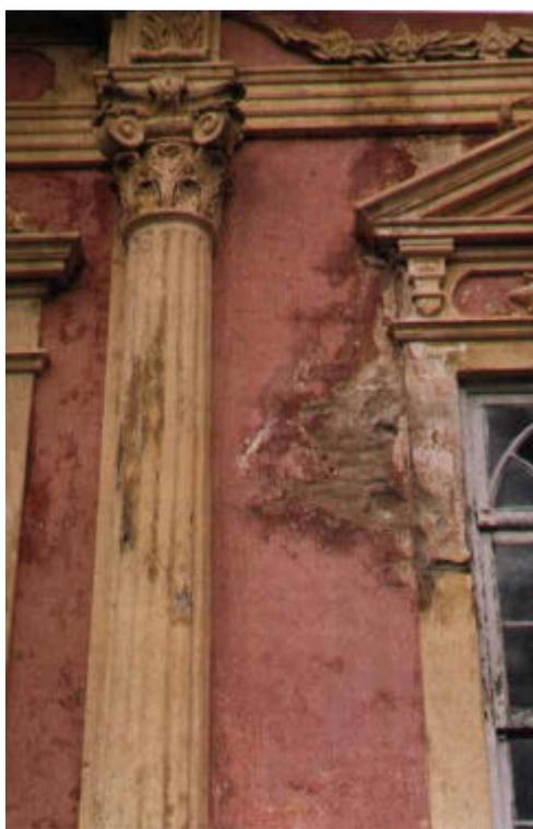
Figura 66 - Pilastra de fuste canelado
