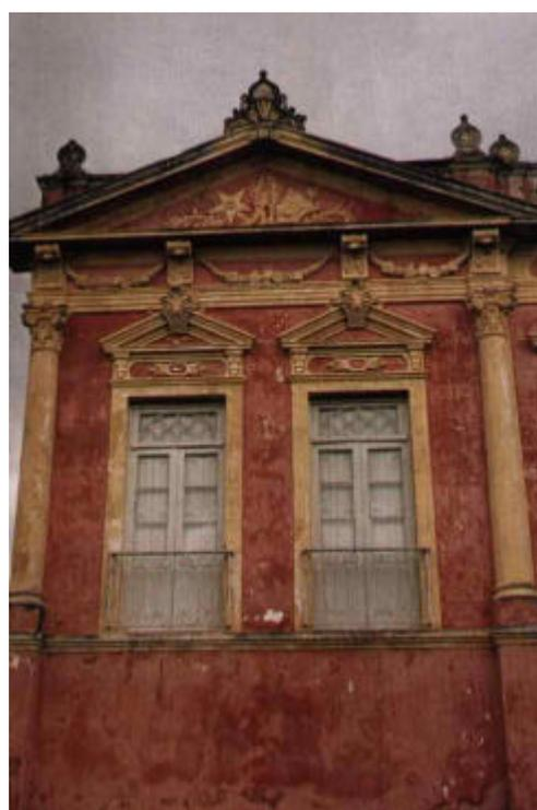
Figura 67 - Pilastra de fuste liso
