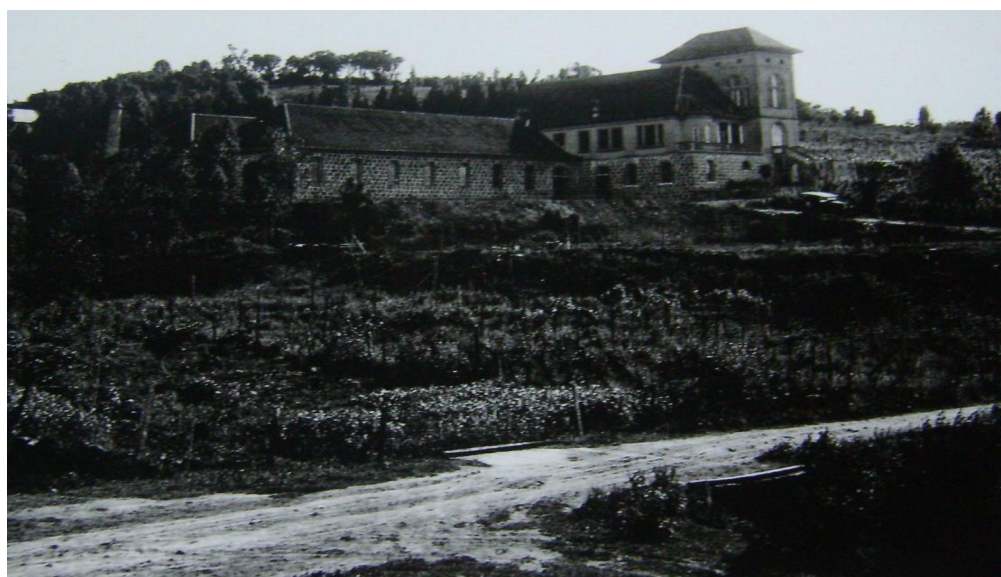
Figura 31 – Construção das novas instalações da vinícola em 1930
