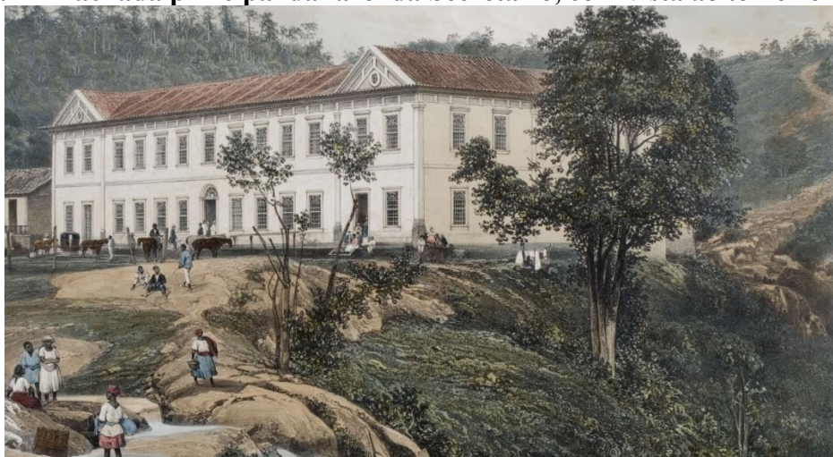
Figura 4 – Fachada principal da fazenda Secretário, com vista ao terreiro de café.
