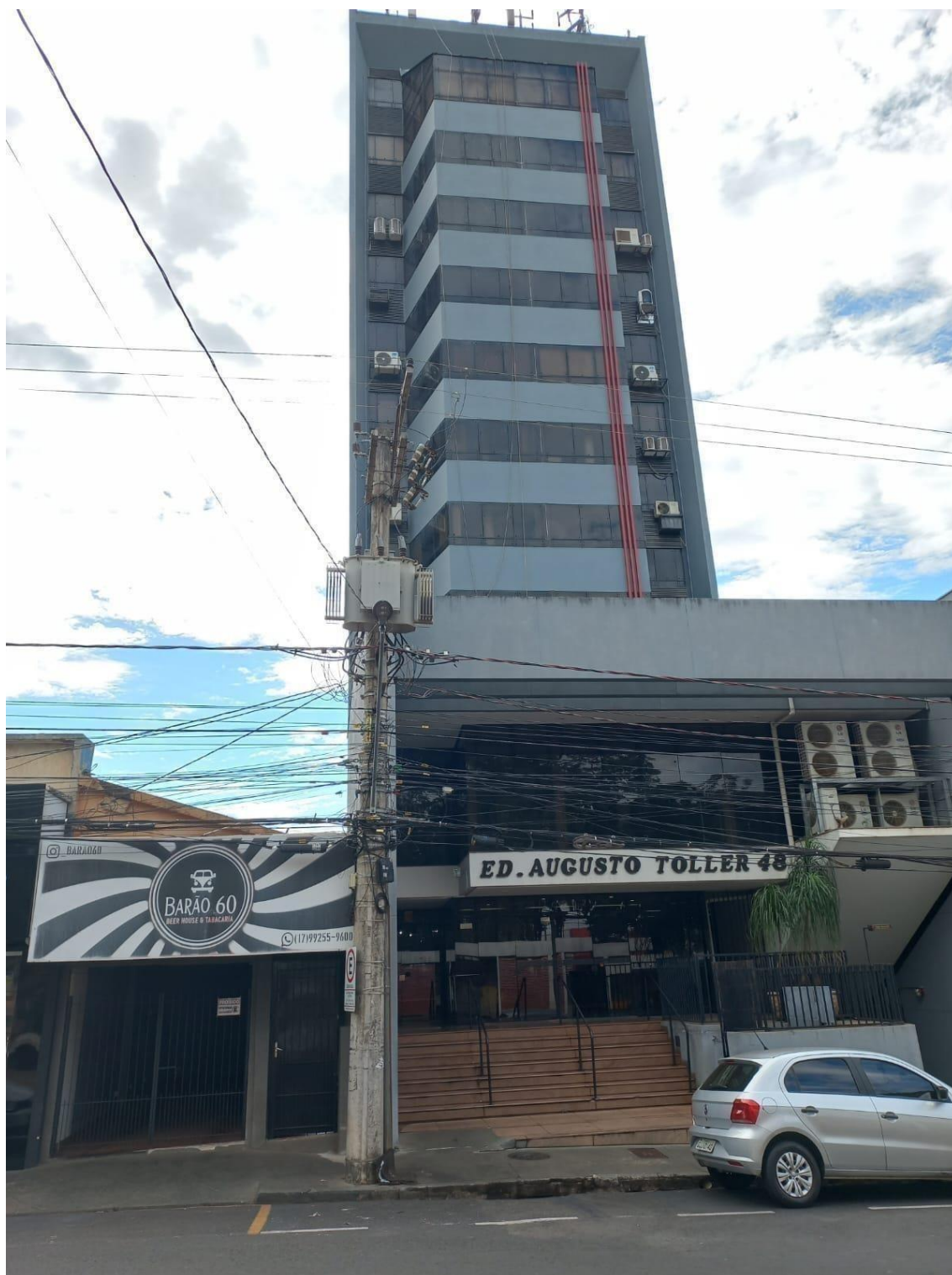
Imagem 66 – Fotografia do Edifício Augusto Toller – localizado na área central de Bebedouro
