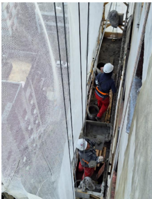
Figura 11 - Tratamento do encunhamento, reforço com tela e reconstituição do emboço (Obra 1)
