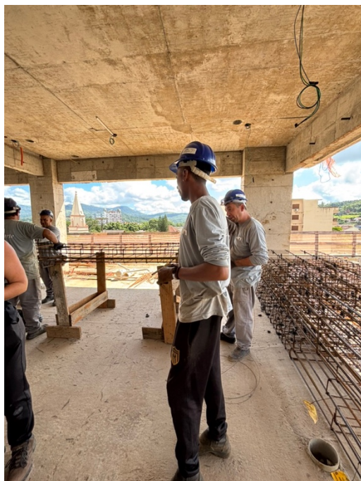
Figura 14 - Armação de ferragem (Obra 2)
