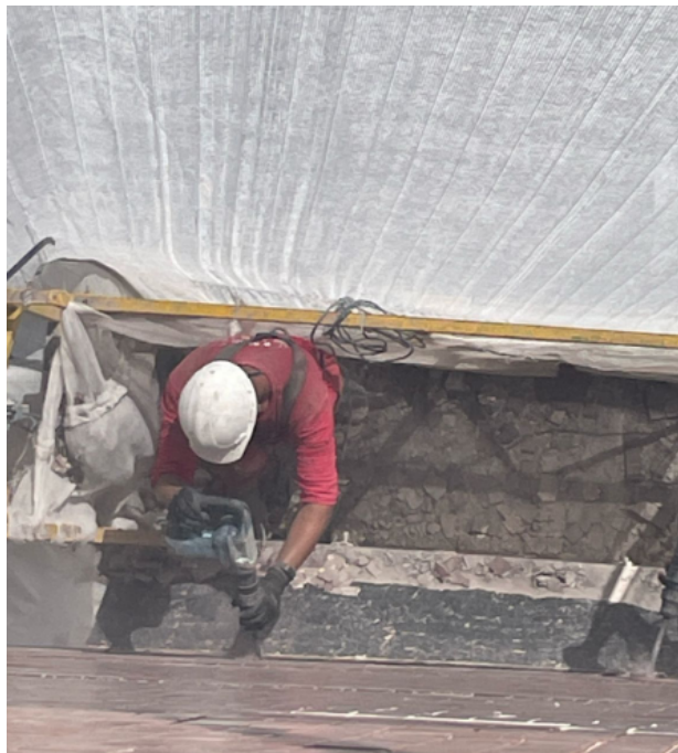
Figura 10 - Atividade de Remoção do emboço entre vigas e alvenaria (Obra 1)
