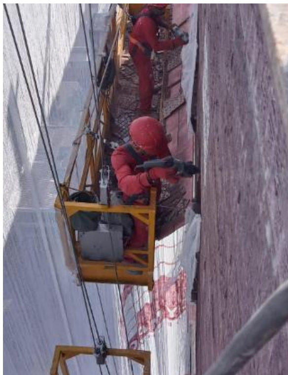
Figura 9 - Atividade de Remoção completa do revestimento cerâmico (Obra 1)
