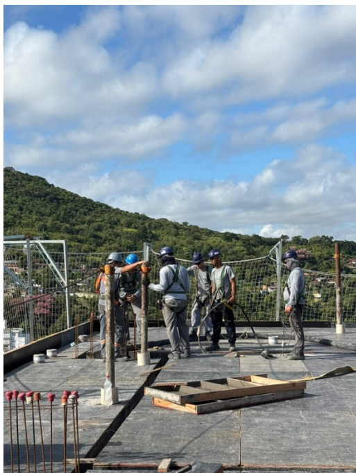
Figura 13 - Concretagem de pilares (Obra 2)
