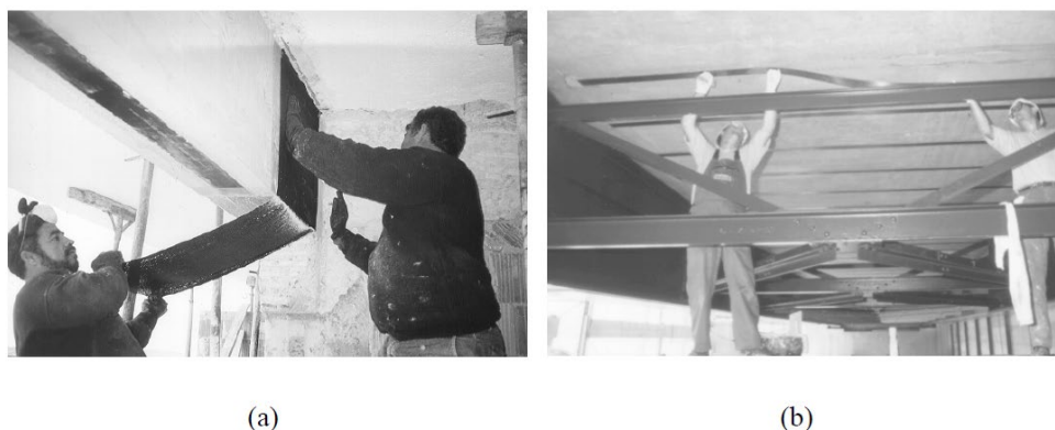
Figura 11 – Aplicações de reforço com PRFC – (a) manualmente com tecido impregnado ou (b) colagem de lâminas.
