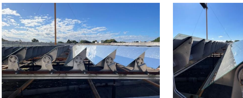
Figura 7.15 Representação do sombreamento (esquerda) dos espelhos e do bloqueio (direita) dos raios incidentes que refletem na parte de trás do espelho adjacente.
