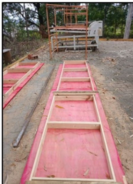
Figura 35 – Fôrmas para moldagem
