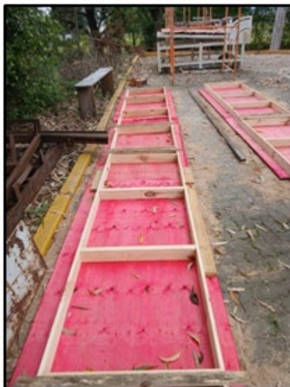
Figura 34 – Estrutura das fôrmas finalizadas
