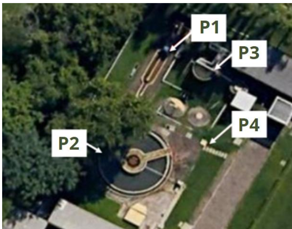
Figura 3 - Imagem aérea da ETE Unisinos mostrando os pontos de coleta de efluente realizadas nesta pesquisa
