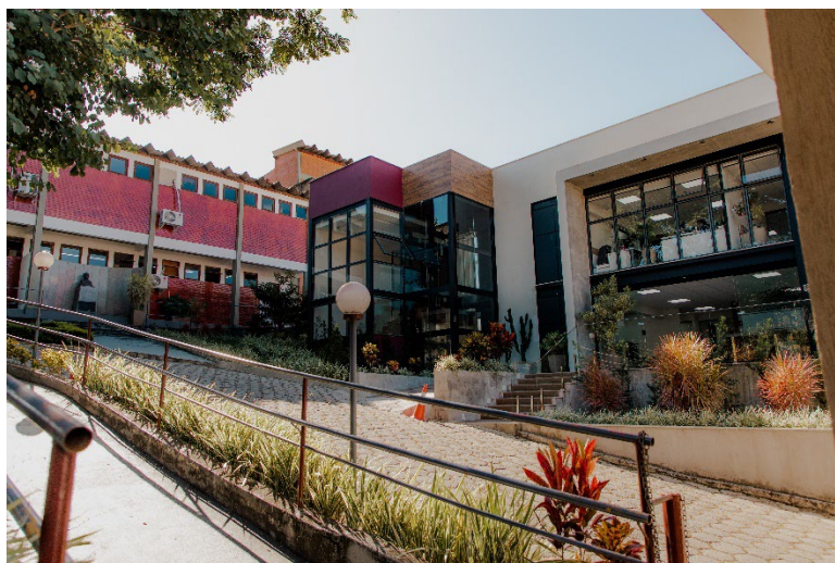
Figura 29 - Prédio Administrativo da FUSVE – 2024
