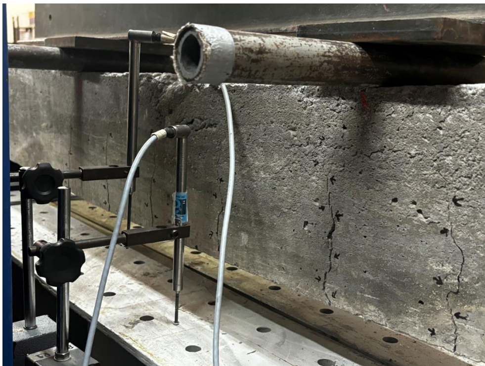
Figura 37 – Trincas verticais na base, com maiores aberturas na parte central
