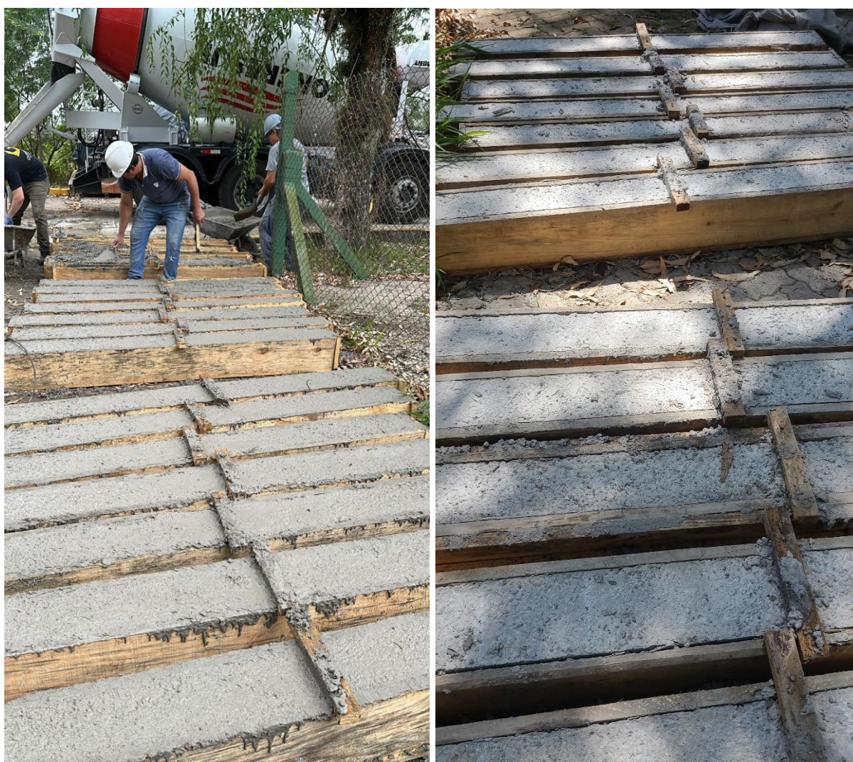
Figura 24 – Concretagem das vigas
