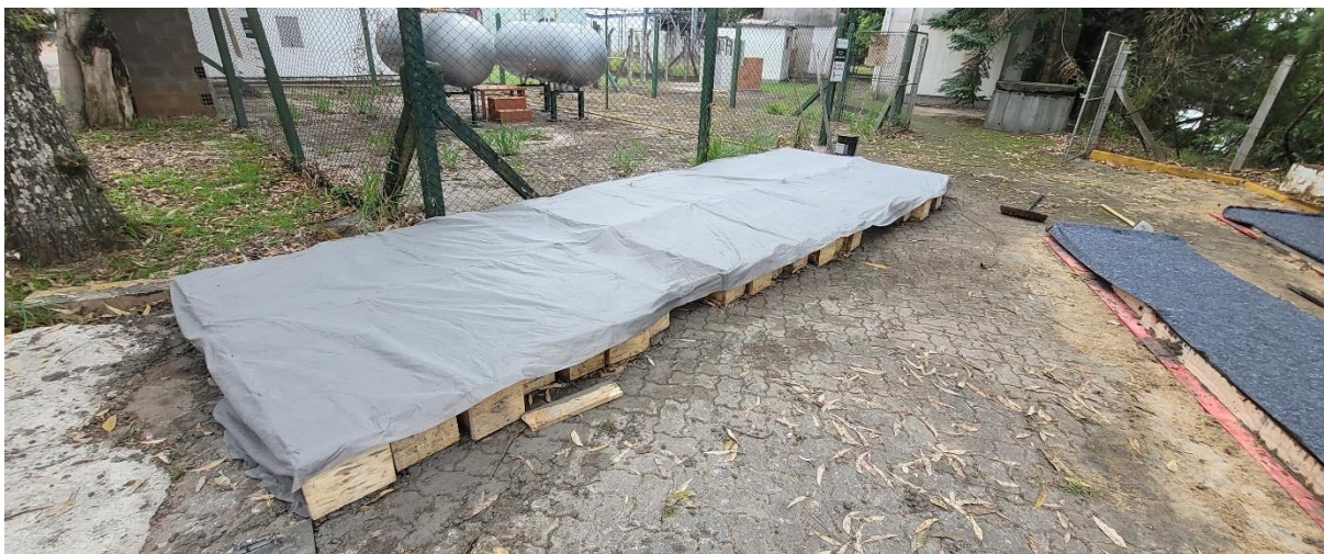
Figura 25 – Vigas concretadas e cobertas com manta geotêxtil
