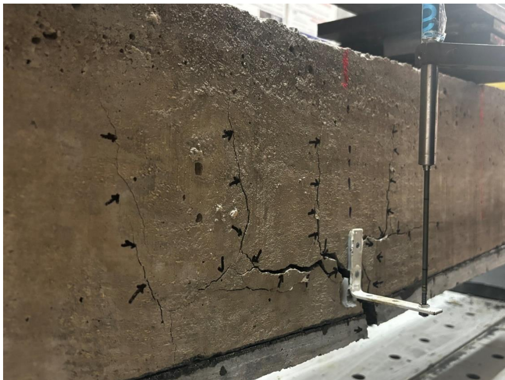
Figura 53 – Rachadura na parte inferior central do reforço, com ramificações
