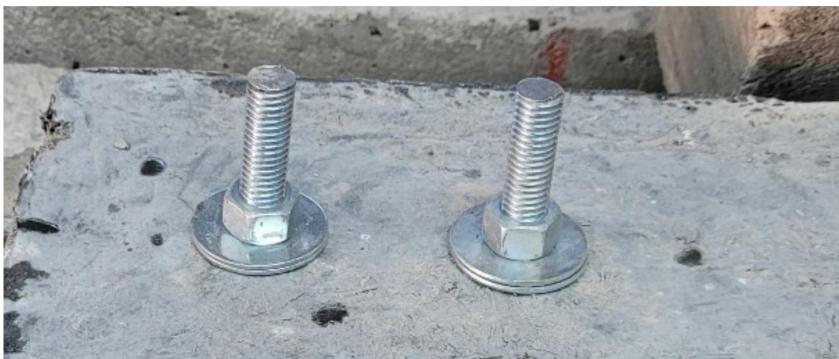
Figura 30 – Detalhe da fixação mecânica dos reforços, com barra rosca e arruelas
