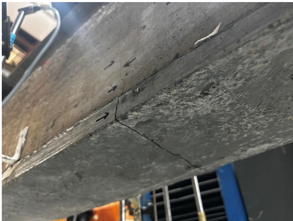
Figura 44 – Fissura vertical na parte inferior central da amostra e do reforço
