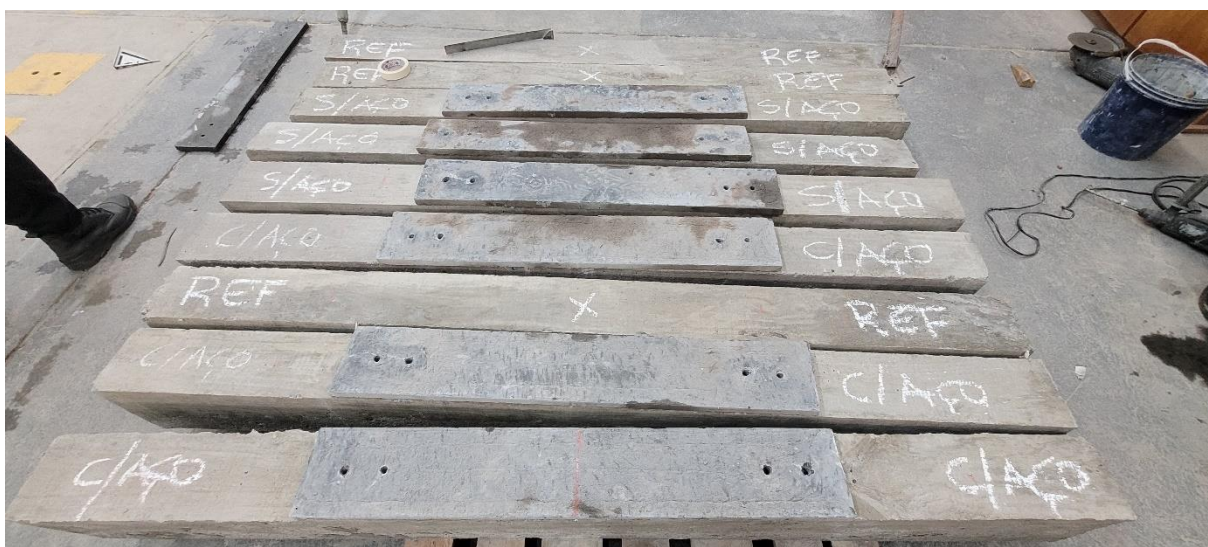
Figura 29 – Reforços colocados sobre as vigas identificadas, antes da fixação
