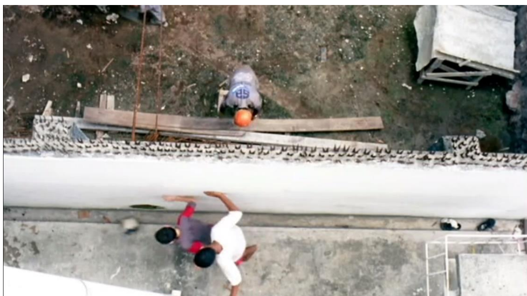
Figura 2 - O muro em Eletrodoméstica
