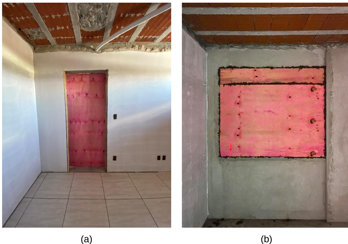
Figura 113 – Portas (a) e janelas (b) provisórias instaladas para os ensaios em campo
