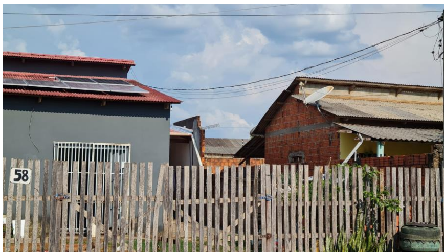
Figura 32 - Casa construídas pelo Projeto Habitar Rio Branco
