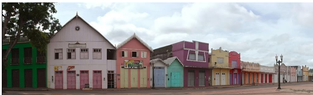
Figura 28 - Vista do conjunto de fachadas históricas da rua da Gameleira, em Rio Branco.
