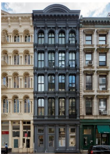
Figura 24 – Visual onde a intervenção não prejudica a fachada.
