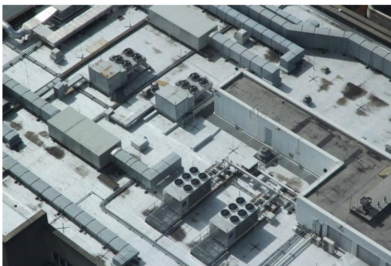
Figura 16 – Coberta composta com área técnica.
