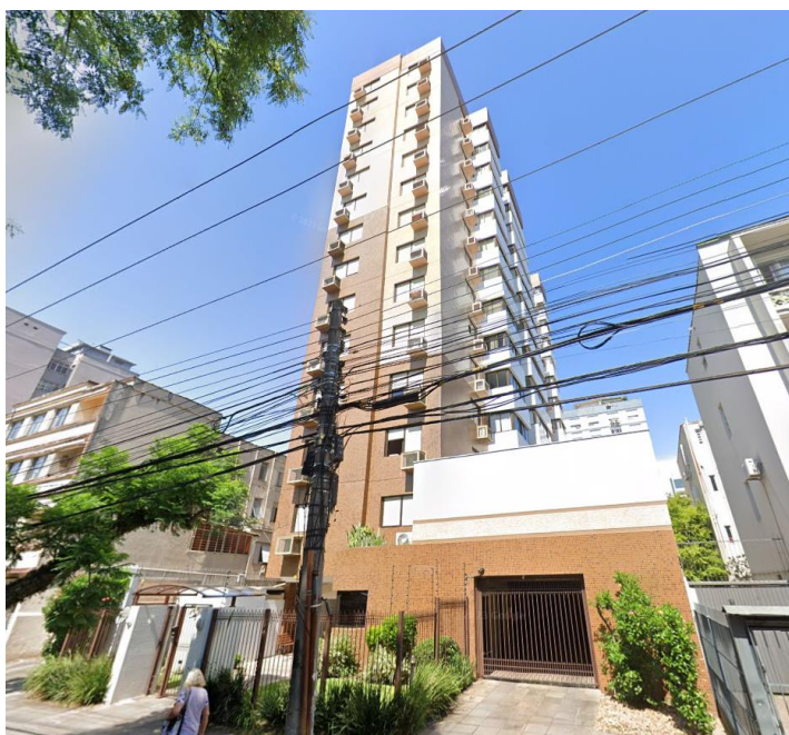
Figura 60 – Edificação 02, Rua Felipe Camarão, bairro Bom Fim
