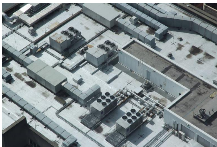
Figura 39 – Exemplo de terraço com excesso de áreas técnicas.
