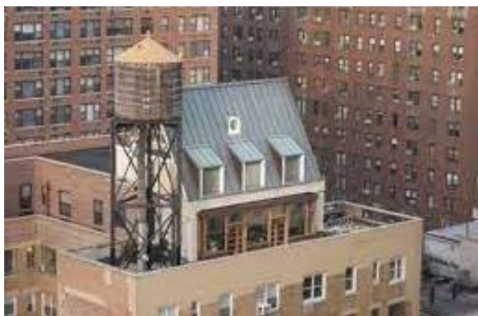
Figura 40 – Exemplo de residência unifamiliar sobre a cobertura.
