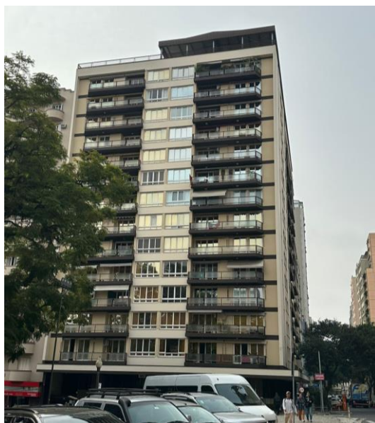
Figura 63 – Edificação 04, Rua Duque de Caxias, bairro Centro Histórico
