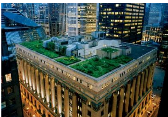
Figura 32 – Cobertura da Prefeitura de Chicago.
