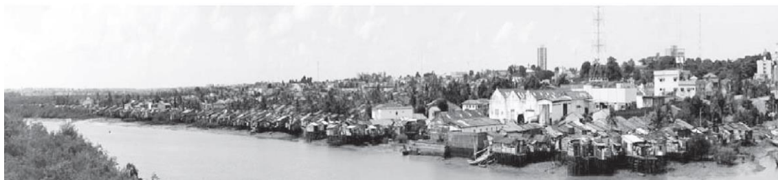
Figura 14 – Ocupação das áreas de mangue por palafitas
