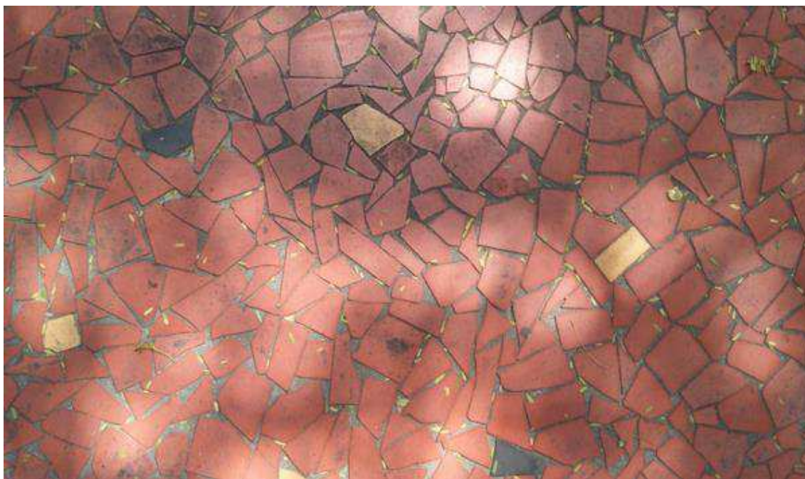
Figura 8 - Imagem de piso de caquinhos.
