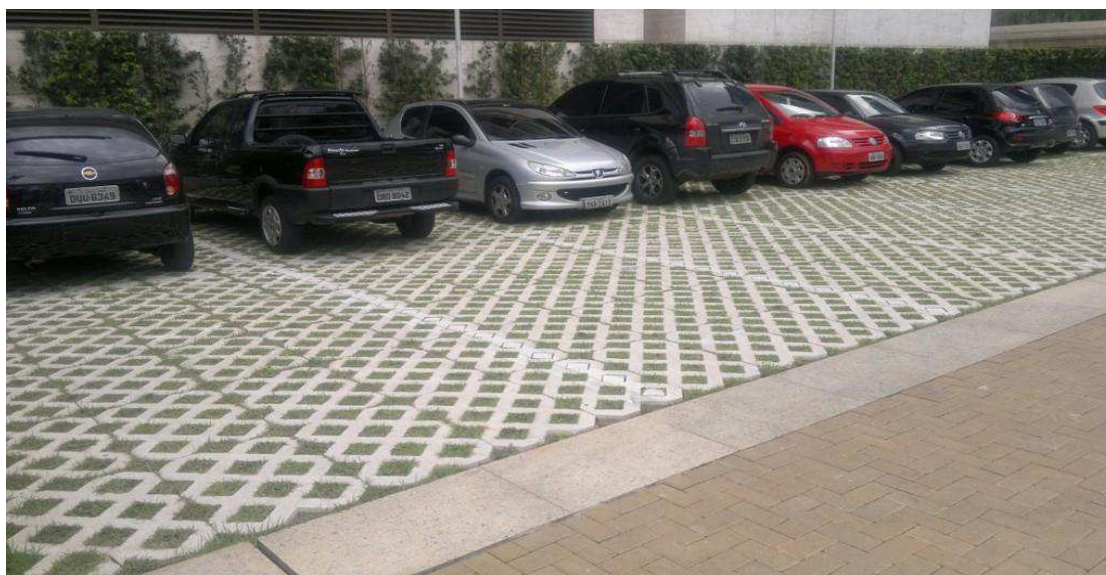
Figura 15 - Exemplo de pisograma que pode ser utilizado como solução para regiões com elevado número de alagamentos, pois permite a drenagem natural das águas pluviais.
