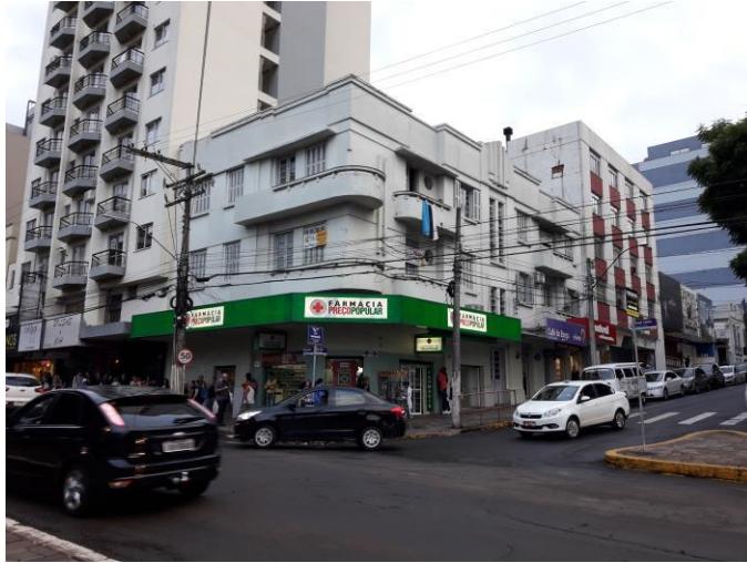
Figura 3 - Edificação nos dias de hoje
