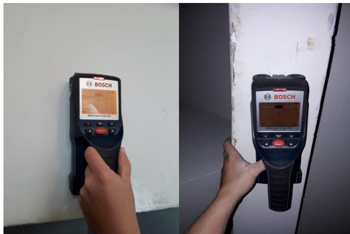
Figura 6 - Aplicação do detector de partículas eletromagnéticas na estrutura (equipamento cedido pelo CETEC da Universidade de Passo Fundo)
