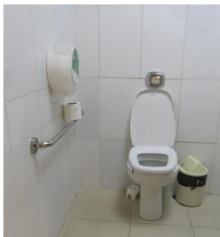
Figura 40 - Bacia sanitária com barra lateral
