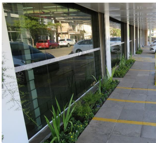
Figura 47 - Faixa sinalizadora em fachadas de vidro
