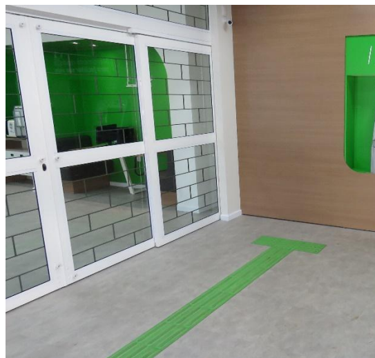
Figura 49 - Piso tátil no interior da agência Dois Irmãos
