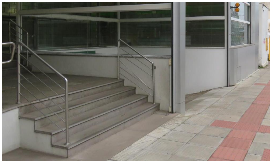
Figura 55 - Escada de acesso à agência Novo Hamburgo - Centro
