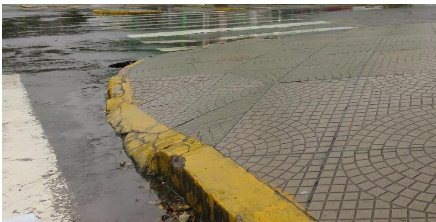
Figura 18 - Rebaixo da calçada
