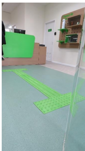
Figura 49 - Piso tátil no interior da agência Dois Irmãos
