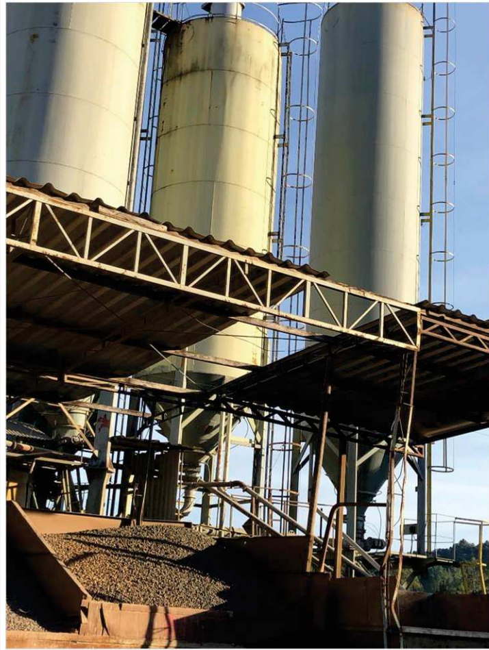
Fotografia C: Silos de Cimento e Baias de Agregados
