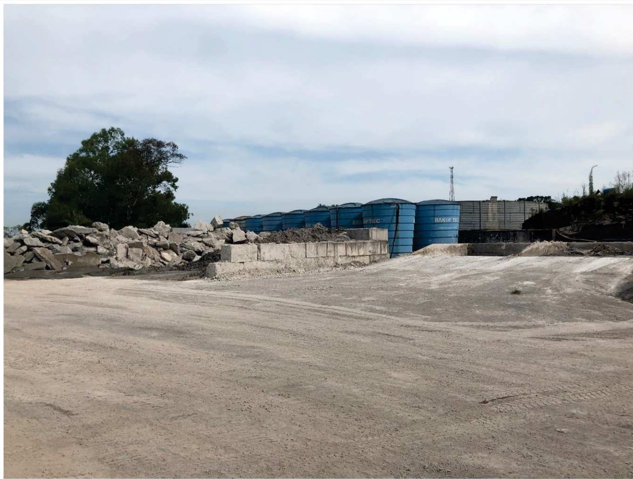
Fotografia S: pátio de dejetos de concreto e tanques reservatório de água para amassamento
