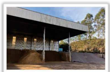
Fotografia 23: Baias de estocagem de agregados
