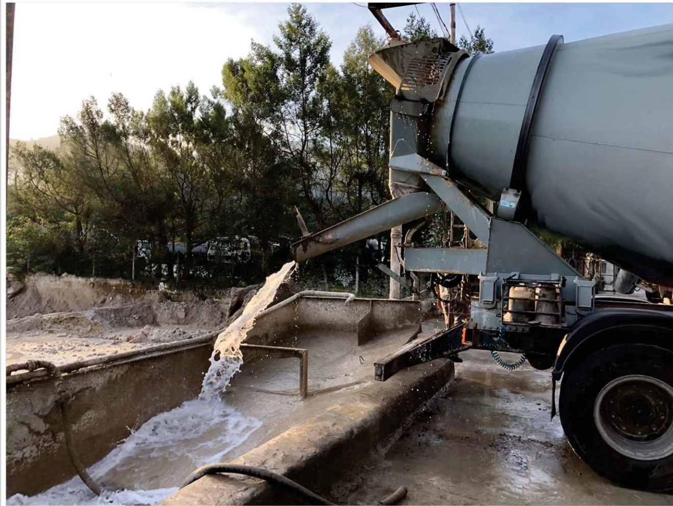
Fotografia R: Betoneira despejando a água de limpeza
