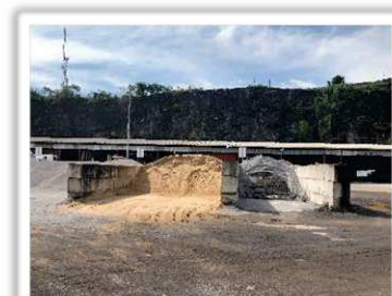
Fotografia 6: Baias de Agregados miúdos
