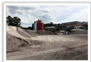
Fotografia 25: Pátio com areia de britagem
