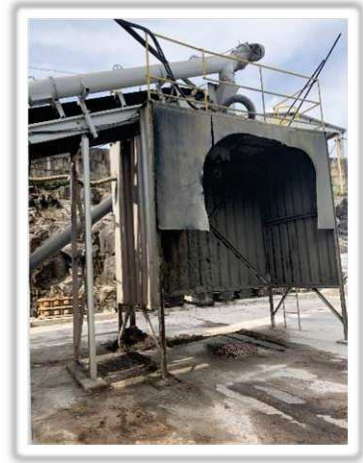
Fotografia 3: Cabine de carregamento das betoneiras
