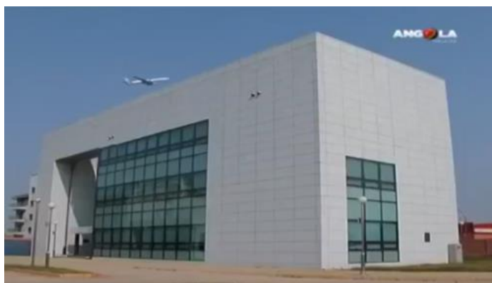
Figura 40 – Prédio do Centro Nacional das Novas Tecnologias Informação (CNTI) localizada na Cidade de Luanda
