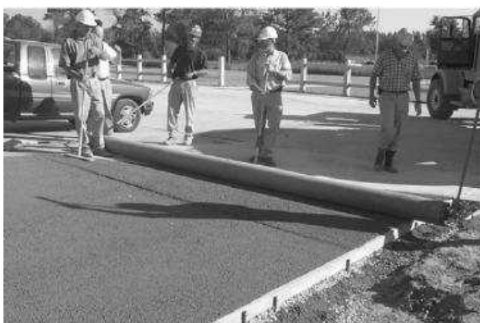
Figura 2 – Exemplo de compactação por rolagem do concreto permeável.
