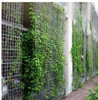
Figura 22 – Rede de cabos de aço
