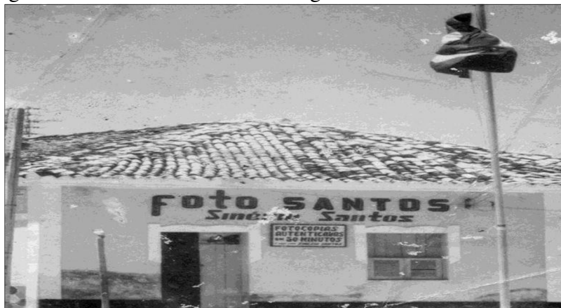
Figura 16 - Fachada do anexo do segundo estúdio de Sinésio Santos
