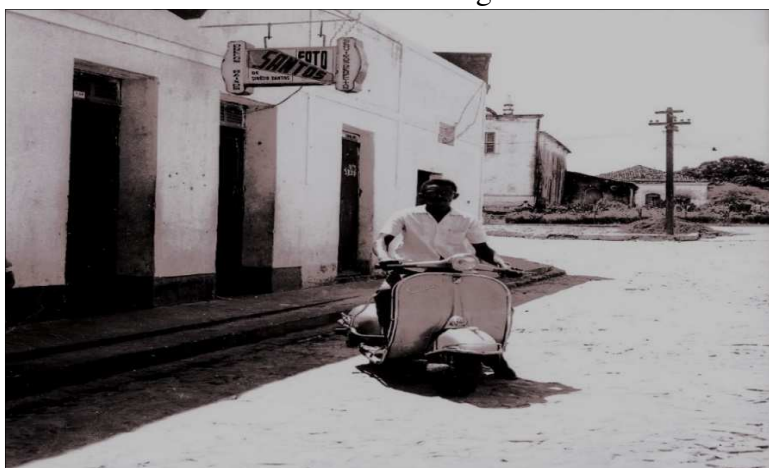
Figura 14 - Fachada do segundo estúdio de Sinésio Santos - década de 1960- Largo do Rosário
