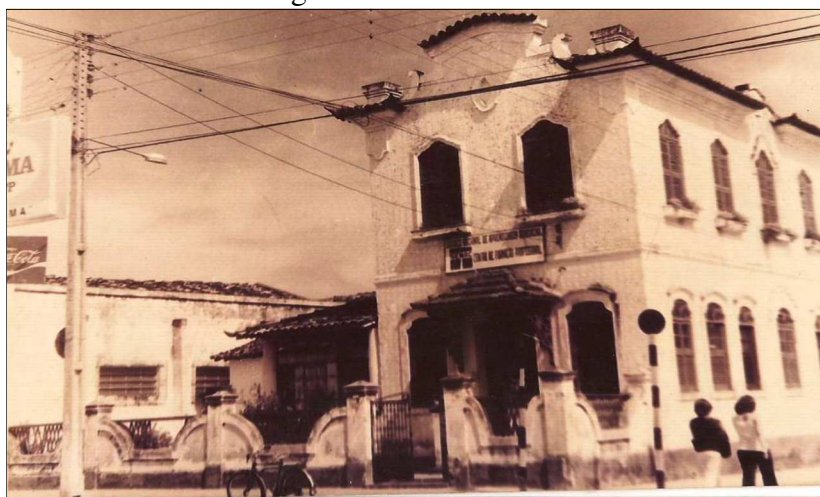
Figura 70 - Fachada do prédio que sediou o SENAC - registro - década de 1990
