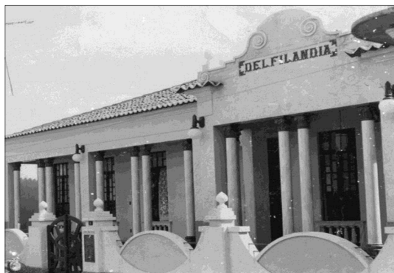
Figura 69 - Fachada da Residência do – década de 1950
