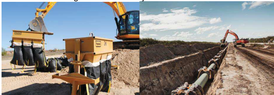
Figura 12 – Instalação de Geotêxteis
