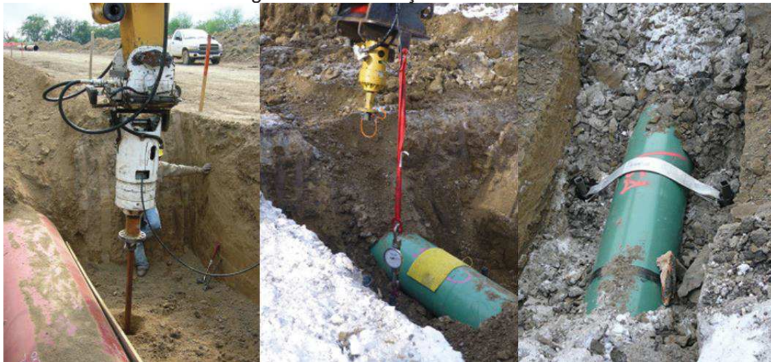
Figura 13 – Instalação de Tirantes
