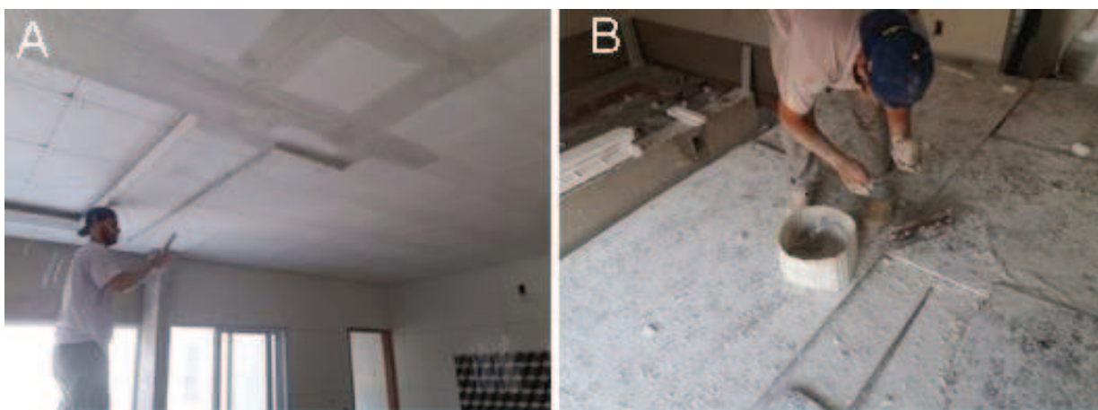
Figura 10 - Pasta de gesso sendo passada para cobrir as juntas (A) e manuseio da pasta de gesso (B)
