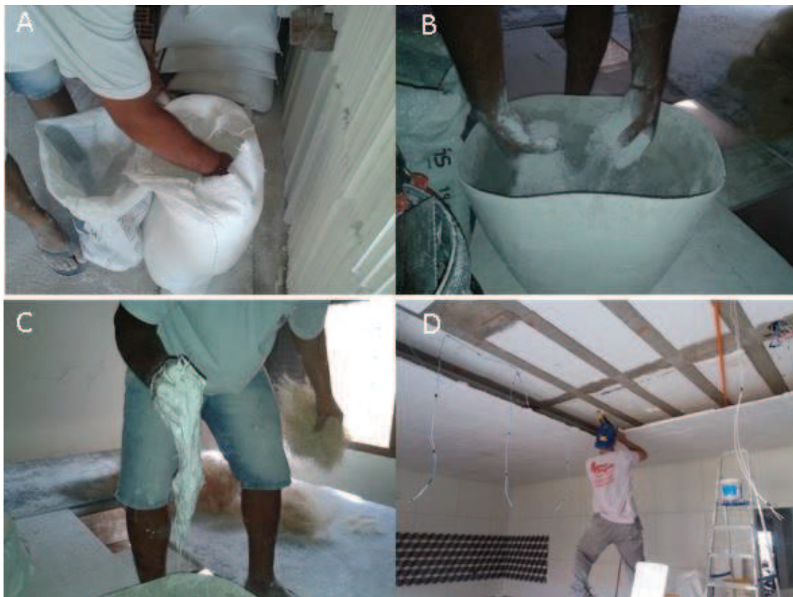
Figura 8 - Etapas da construção do forro de gesso: pó de gesso (A), mistura do pó de gesso com água (B), processo de homogeneização da mistura com sisal (C) e forro de gesso sendo executado (D)
