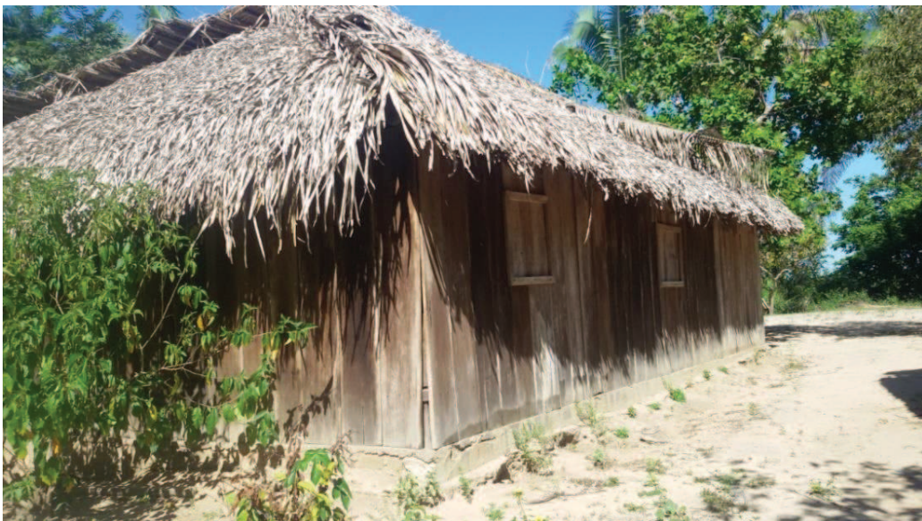
Fotografia 2 - Construção típica da ilha
