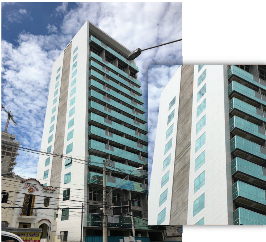
Fotografia 4 – Fachada ventilada com placas cerâmicas
