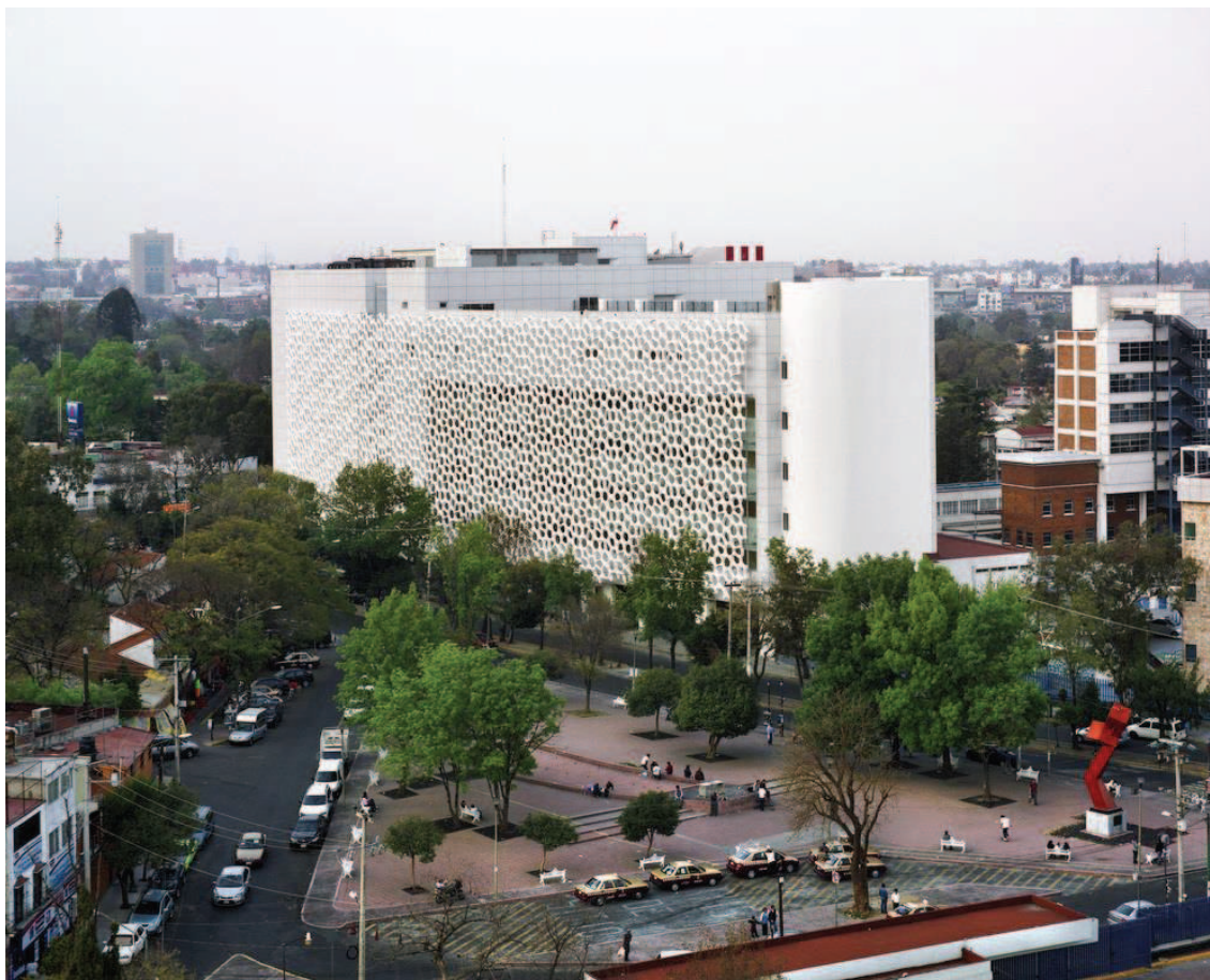
Fotografia 3 - Fachada que utilizou dióxido de titânio em sua execução
