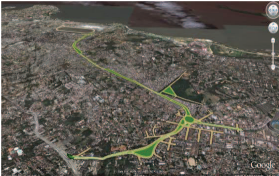
Figura 29 – Traçado da Avenida Tronco (Moab Caldas). Principal obra de mobilidade Urbana da Matriz de Responsabilidades da Copa do Mundo Fifa 2014. Fonte: Material apresentado pelo Secretário de Governança Buzzato em audiência pública ocorrida em 25 de março de 2011 na Assembleia Legislativa do RS.
