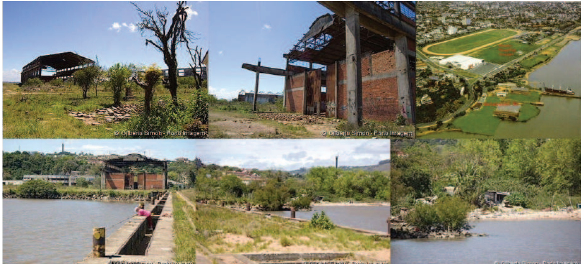
Figura 23 – Imagens da área do Estaleiro Só. Fonte: Henrique Wittler.
