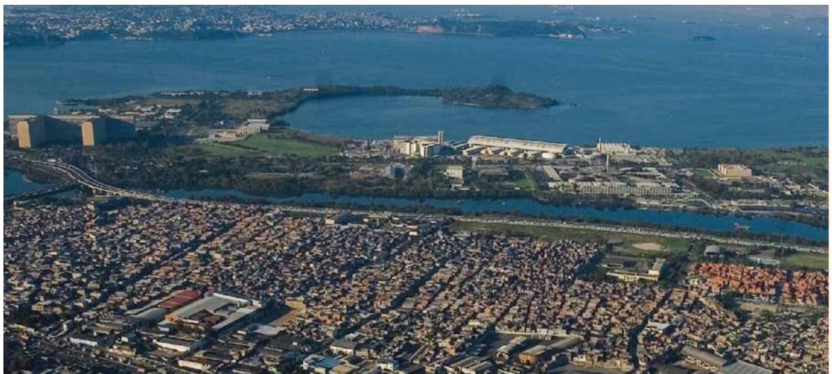
Imagem 18 - Inserção urbana do conjunto de edifícios que compõe a Universidade Federal do Rio de Janeiro (UFRJ) na malha urbana da cidade do Rio de Janeiro - RJ.
