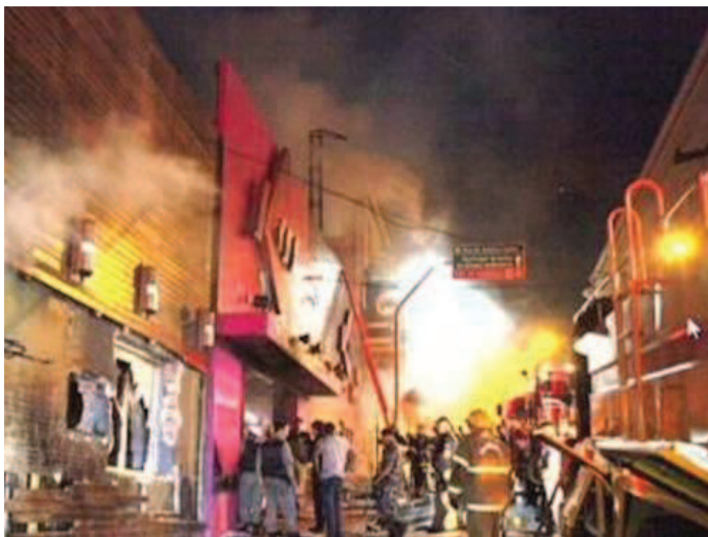
Figura 6 – Incêndio na Boate Kiss em Santa Maria
