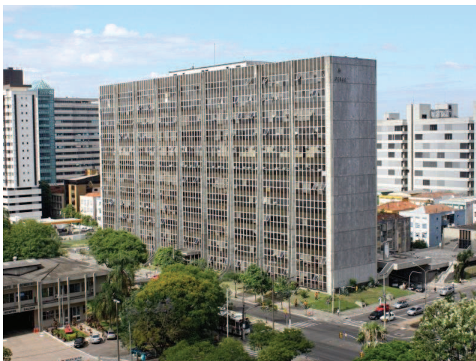
Fotografia 2 – Estrutura da edificação
