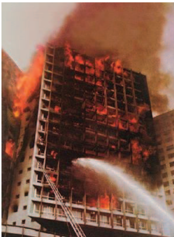
Figura 3 - Incêndio no Edifício Joelma em São Paulo
