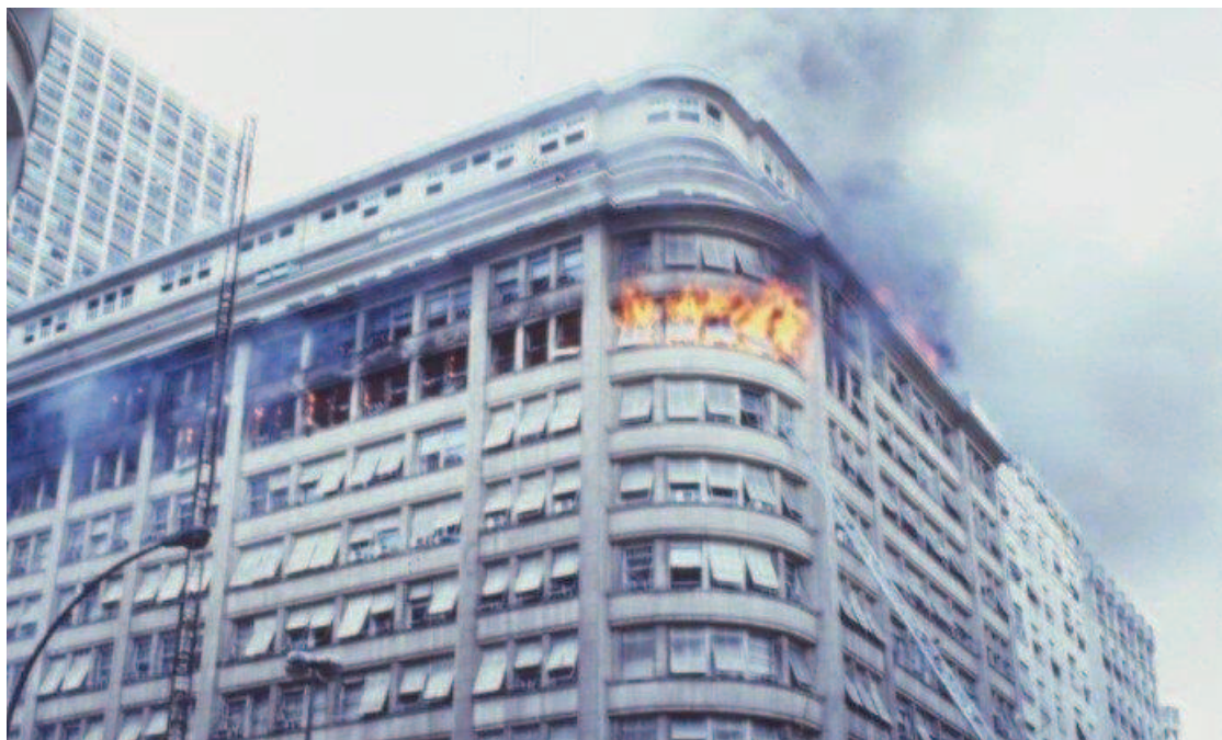
Figura 5 – Incêndio no Edifício Andorinhas no Rio de Janeiro
