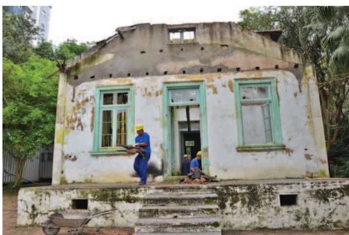
Fotografia 34 – Casa dos Rosa no início da restauração
