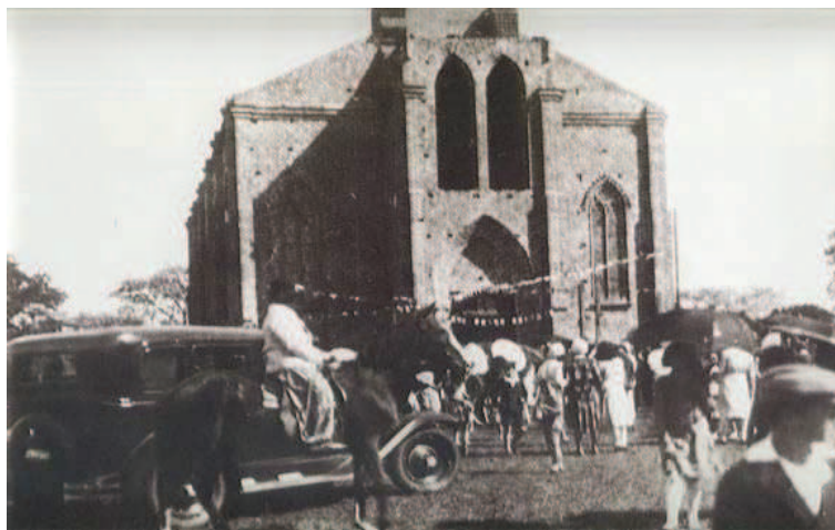
Fotografia 46 – Igreja Matriz São Luiz Gonzaga em construção, 31 de março de 1931
