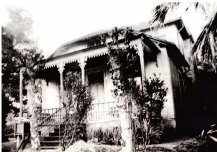
Fotografia 33 – Casa dos Rosa em situação de abandono
