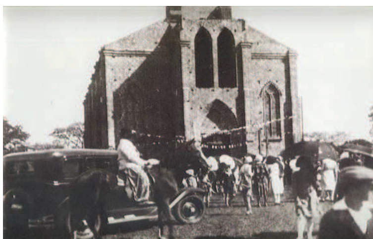
Fotografia 21 – Igreja Matriz em construção
