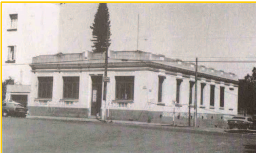
Figura 8 – Residência dos Vergueiro
