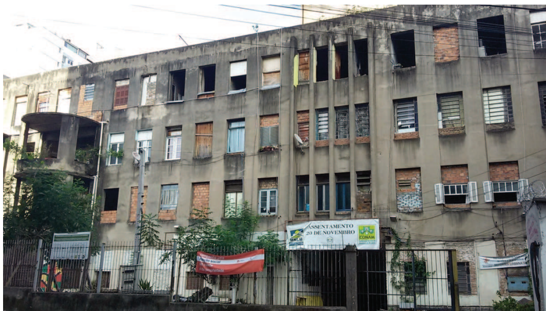
Fotografia 7 - Fachada do Assentamento 20 de Novembro
