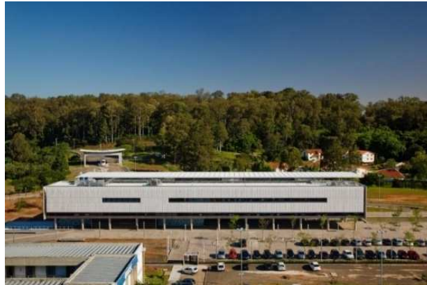
Figura 11– Vista externa da edificação
