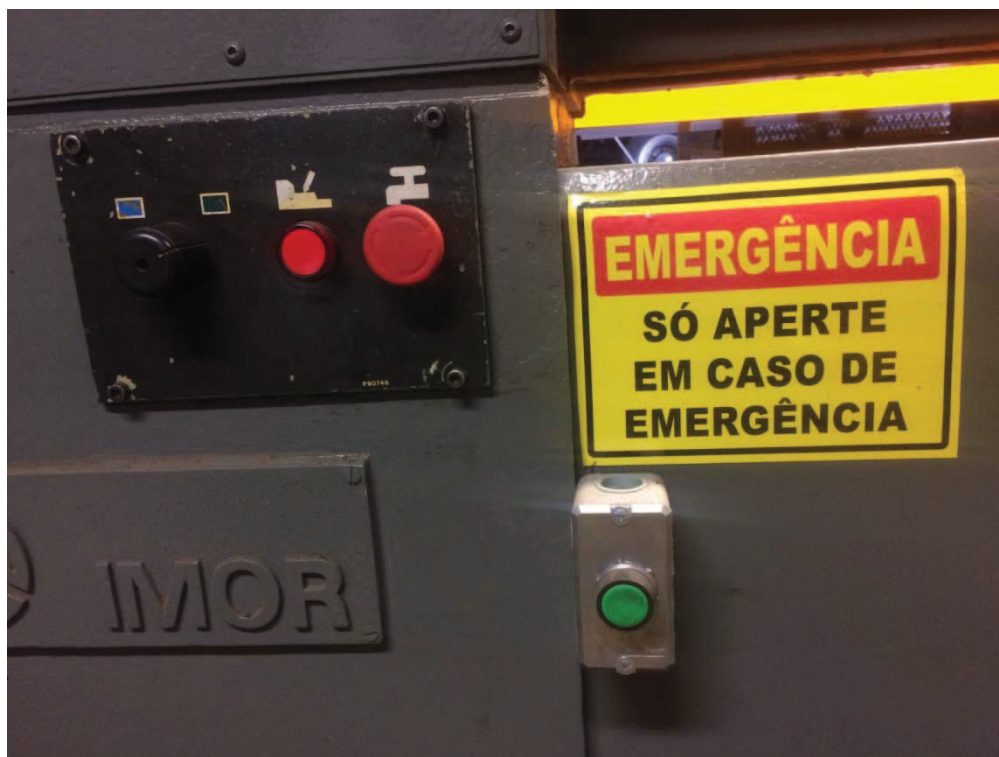
Figura 16 - Instalação da botoeira de emergência e de rearme
