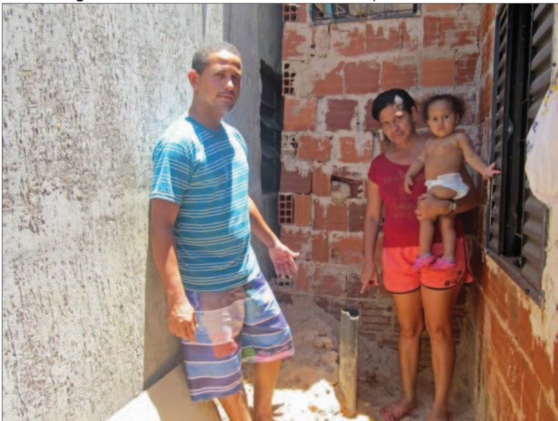
Figura 26: Moradores mostrando a fossa séptica em sua casa
