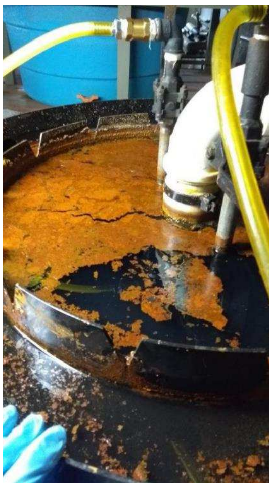
Figura 27 – Acúmulo de espuma durante a operação do reator UASB
