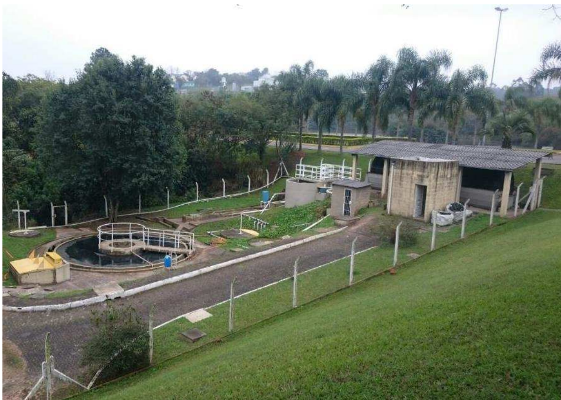
Figura 12 – Visão geral da ETE UNISINOS
