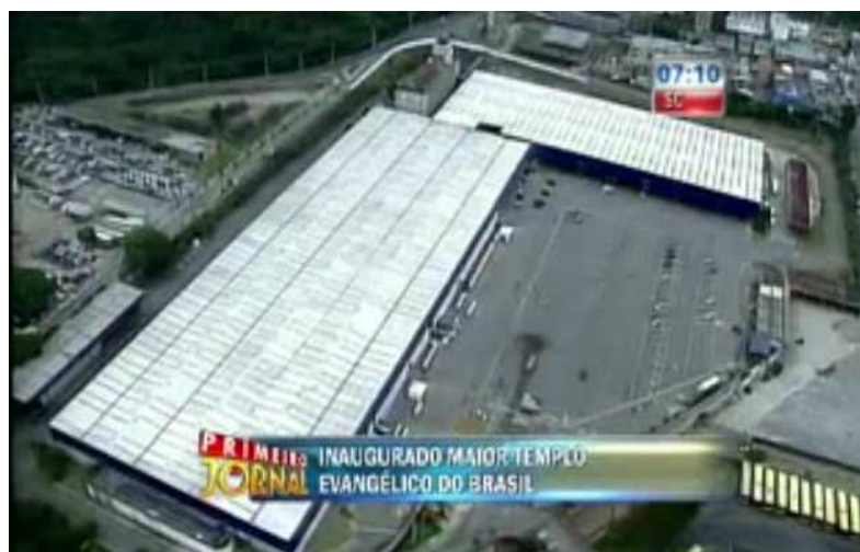
Figura 66 - Frame com imagem de reportagem aérea realizada pelo Primeiro Jornal da BAND, Cidade Mundial dos Sonhos de Deus. Inaugurado em 2011, este templo religioso possui capacidade para 150 mil pessoas, e é considerado um dos cinco maiores do mundo. e o engarrafamento diário que ela ocasiona.
