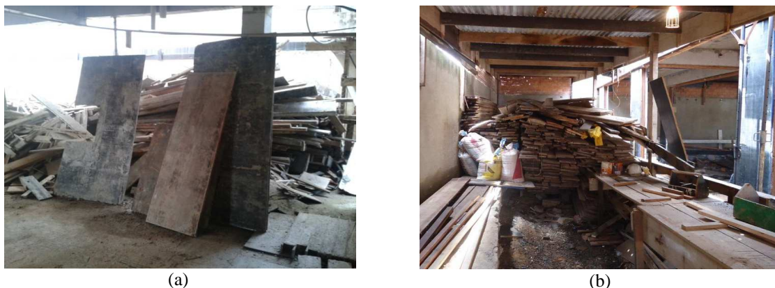
Figura 12 – (a) Resíduo de madeira armazenado em C3 e (b) armazenado em C4
