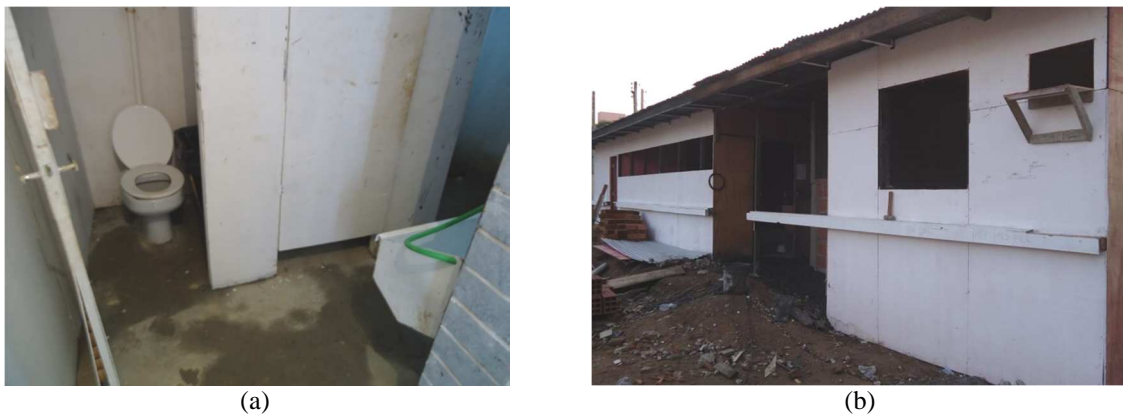
Figura 11 – (a) Sanitário da obra C3 e (b) Canteiro da obra C4 sendo executado
