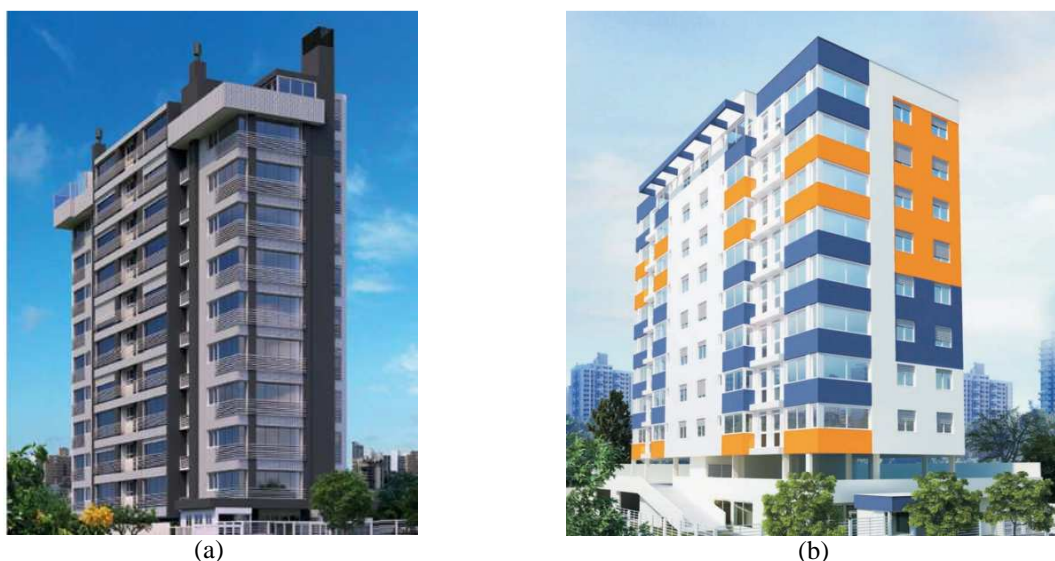
Figura 5 – (a) imagem da obra C3 e (b) imagem da obra C4
