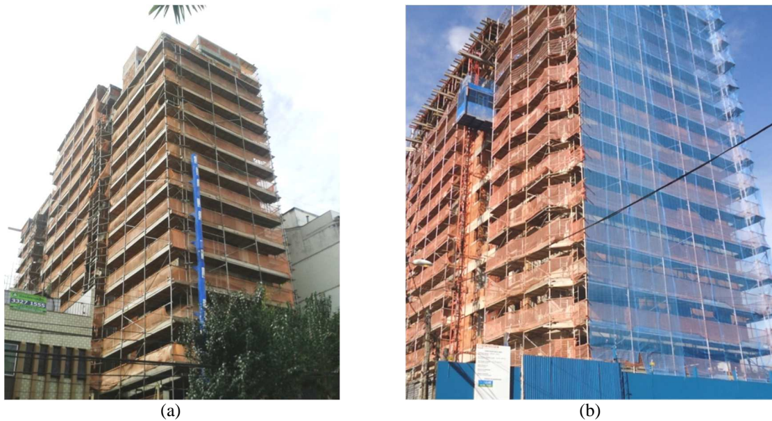
Figura 10 – (a) Obra C3 e (b) Obra C4
