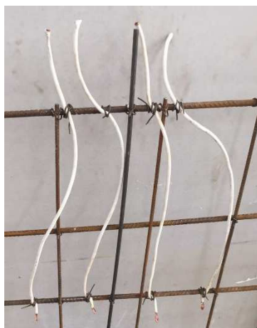
Figura 18 – Fixação e disposição nas armaduras.
