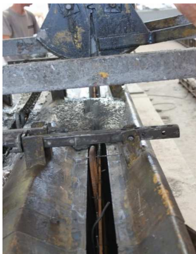
Figura 26 – Concretagem das placas.
