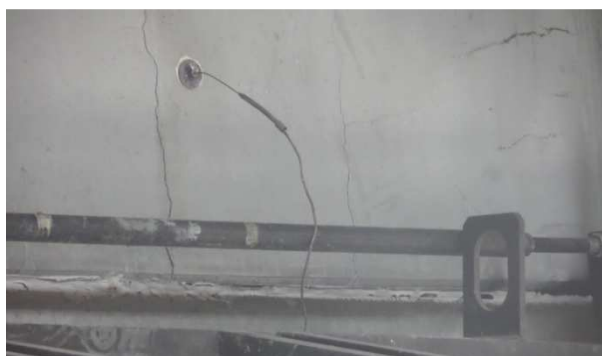
Figura 47 – Fissuras após evaporação da água – amostra com 14 dias de cura.
